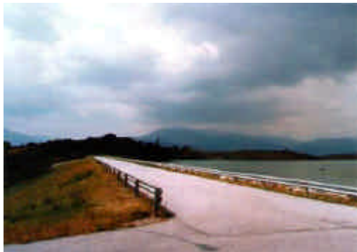
Depósito regulador de Charco Redondo (Foto Confederación Hidrográfica del Sur)
