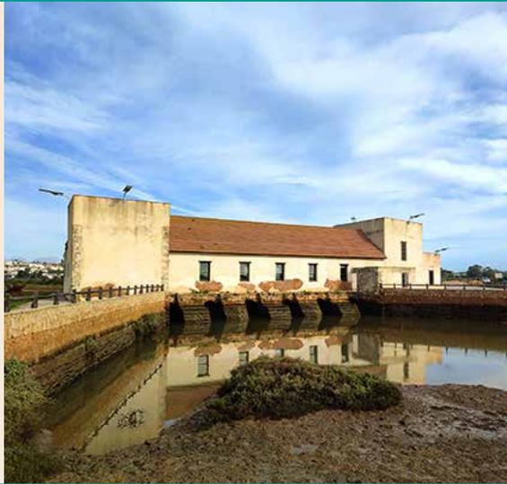
Quando a maré baixa o suficiente, erguem-se desde a sala da moagem as comportas dos quebra-mares, que são as que se encontram suspensas por roldanas sobre o muro de pedra. Desta forma, a cachoeira transmite a energia necessária para fazer girar o rodízio, que por sua vez faz movimentar as pedras.
