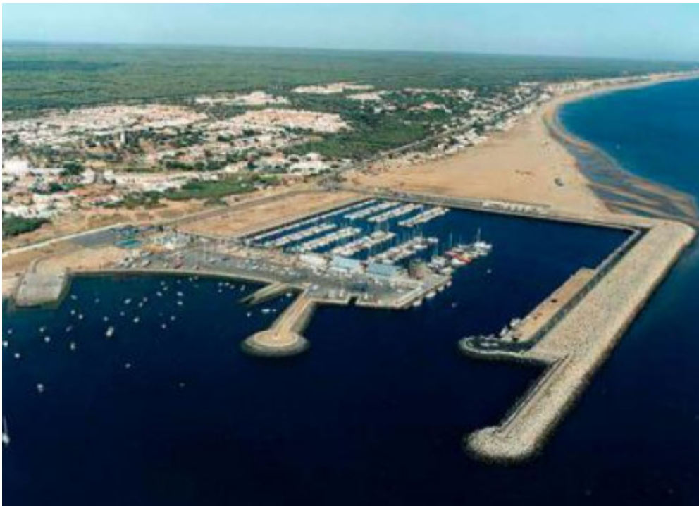
Figura nº 21. Puerto de Mazagón
