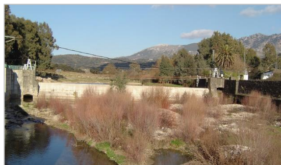
Figura nº 6. Presa de la Buitrera, en el río Guadiaro
