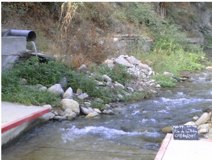
Figura 3. Tubo de vertido junto a la estación de aforos del río de la Toba (04/10/2011).
