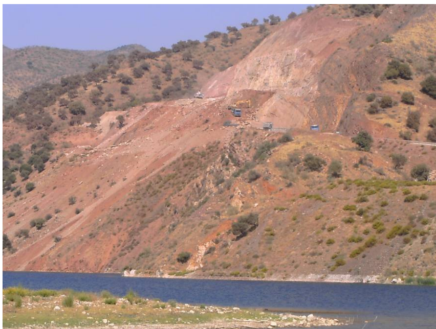
Figura 9. Obras en la ladera de una montaña junto al Embalse de Casasola (06/10/2011)
