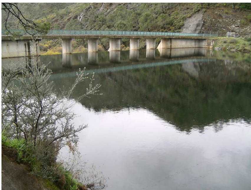
Figura 15. Presa del Guadaiza (24/01/2011)
