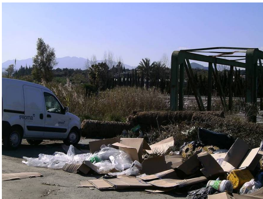
Figura 1. Basuras junto al puente sobre el Río Fahala, estación MA607 (01/02/2011).
