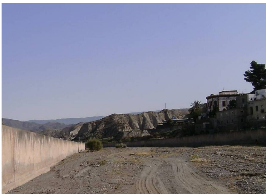
Figura 5. Cauce seco del río Nacimiento (12/01/2011).
