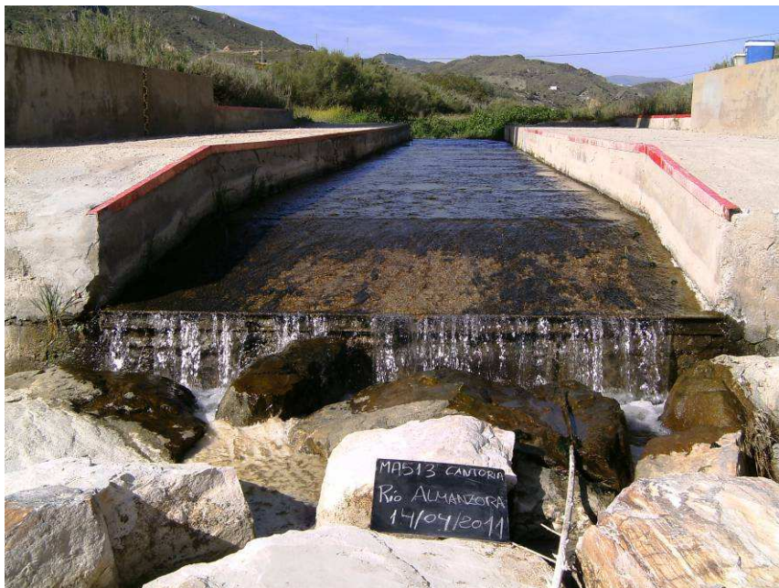
Figura 12. Estación de aforos en Cantoria (14/04/2011)
