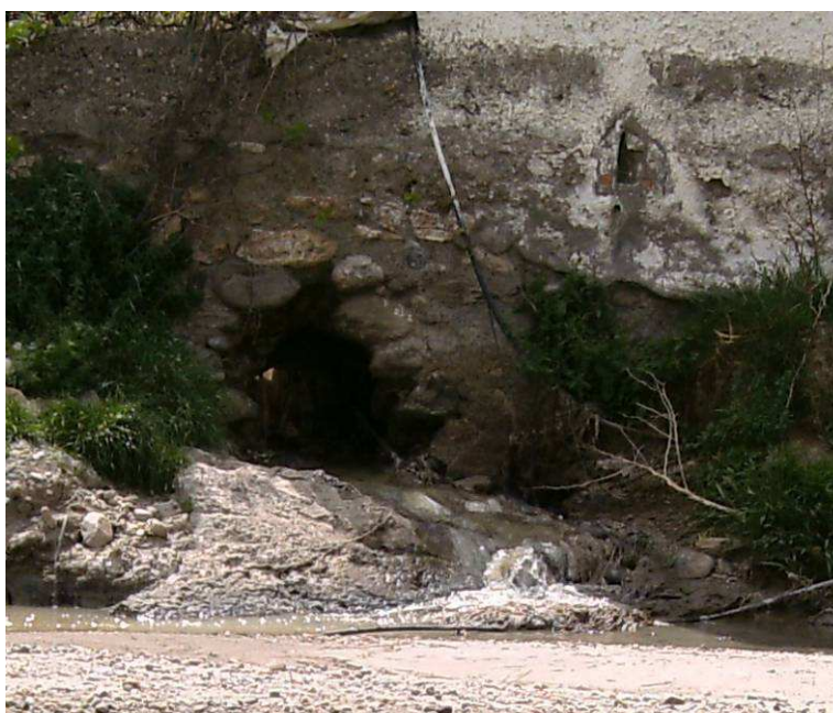
Figura 9. Detalle del punto de vertido de la depuradora de Gádor (12/04/2011)
