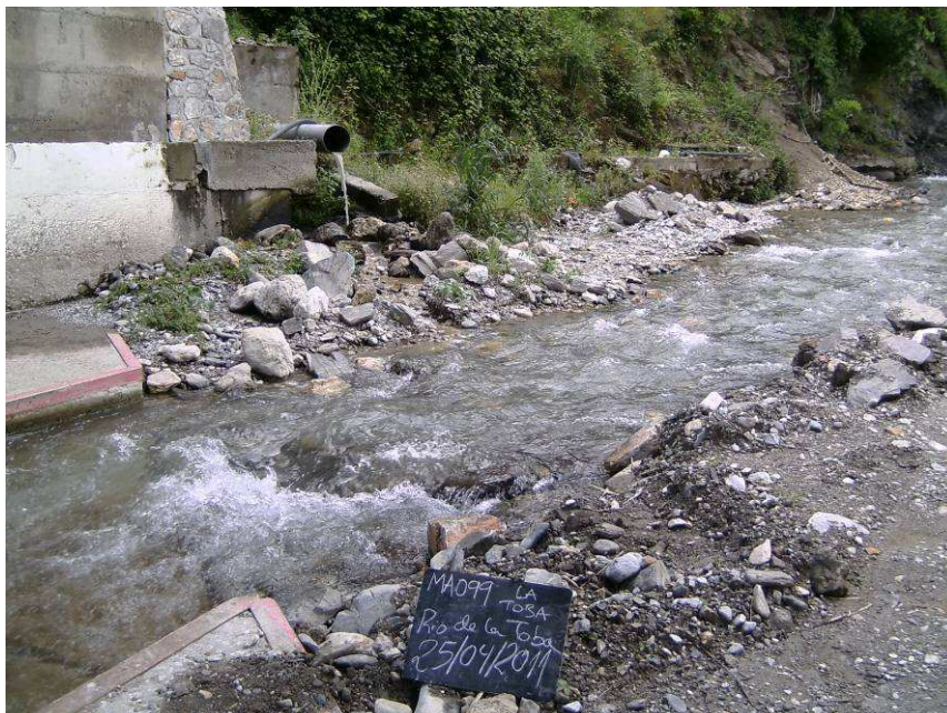
Figura 16. Tubo de vertido de aguas residuales aguas arriba de estación de aforos (25/04/2011)
