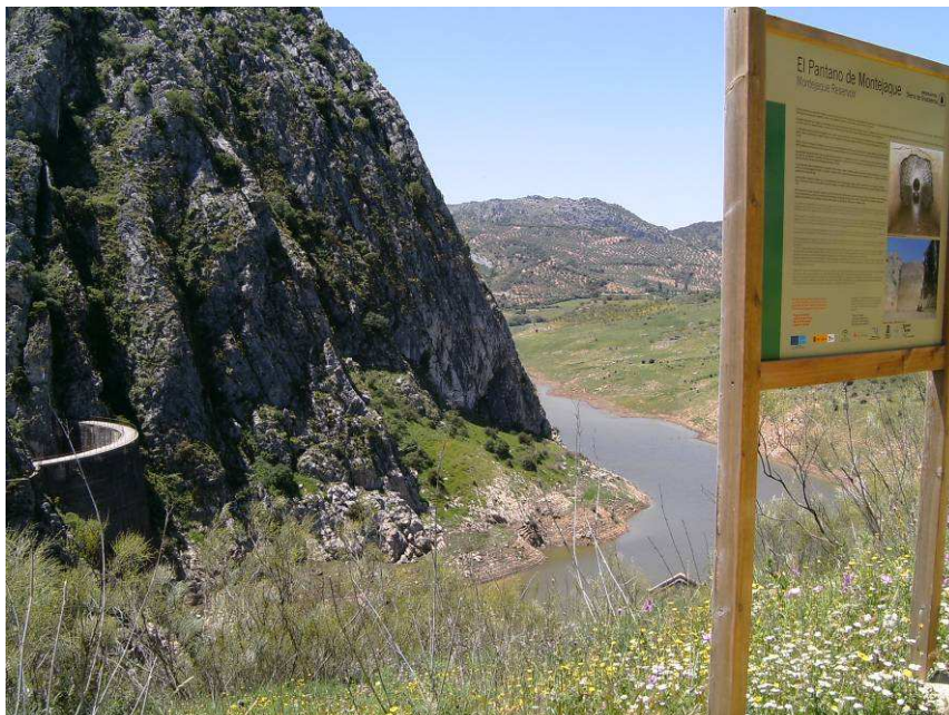
Figura 6. Presa de Montejaque (09/05/2011).
