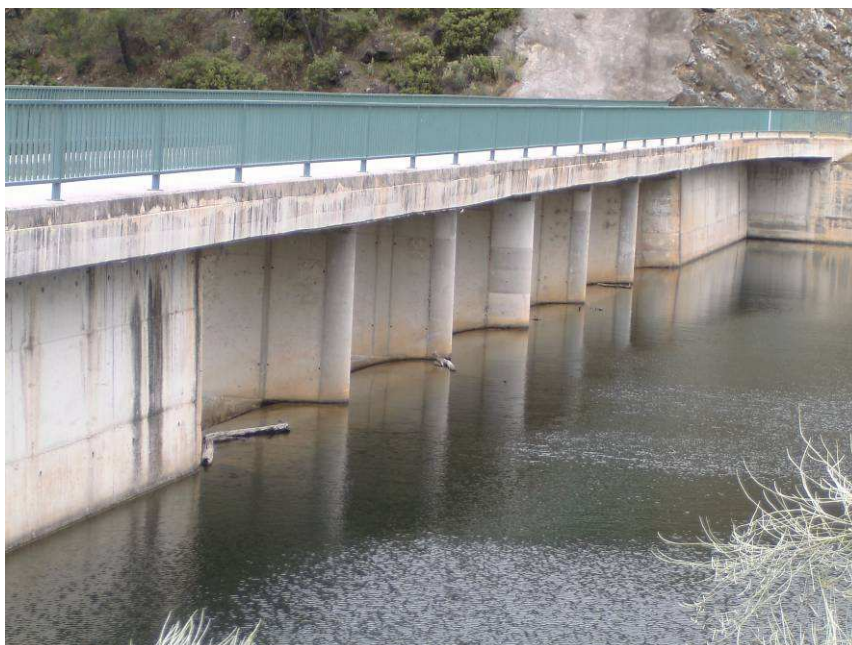
Figura 13. Presa del Guadaiza completamente llena (17/05/2011)
