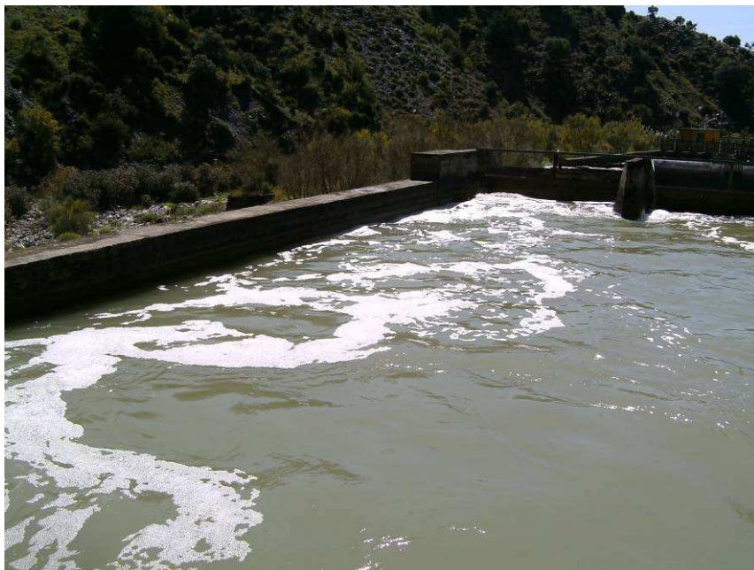
Figura 2. Aspecto del agua en el canal de la estación de muestreo MA149 (03/05/2011).
