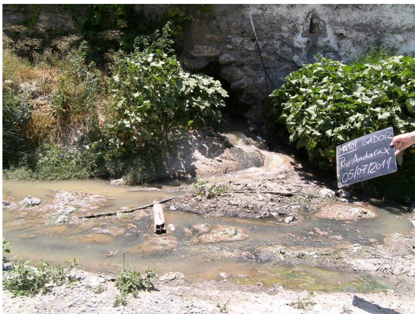
Figura 4. Punto de vertido de la depuradora de Gádor al cauce del Andarax (05/07/2011).
