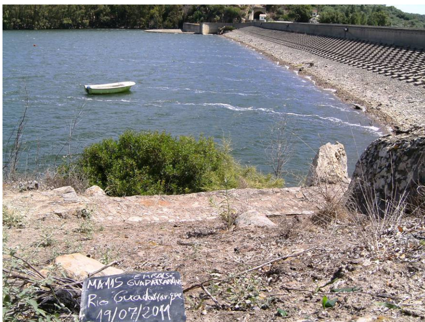
Figura 15. Vista del muro del Embalse de Guadarranque (19/07/2011)
