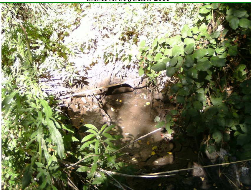
Figura 14. Punto de vertido de la depuradora al cauce del río Torrente (13/07/2011)
