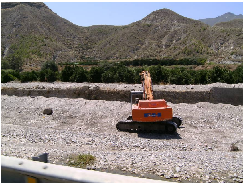
Figura 3. Excavadora en el cauce del río Andarax (05/07/2011).
