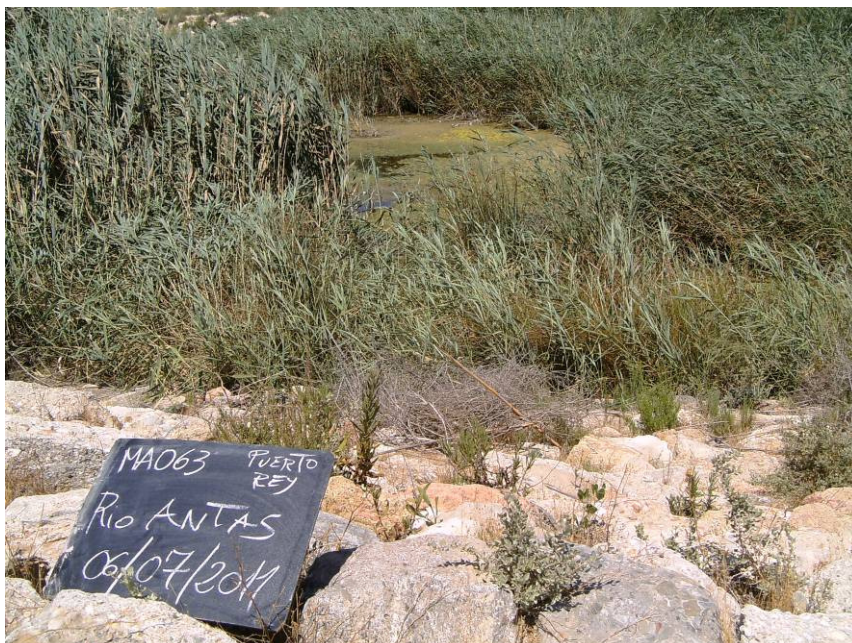
Figura 6. Agua estancada en la estación de muestreo MA063 (06/07/2011).
