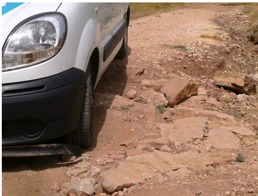
Figura 1. Carril de acceso a la estación MA003 en mal estado (01/08/2011).
