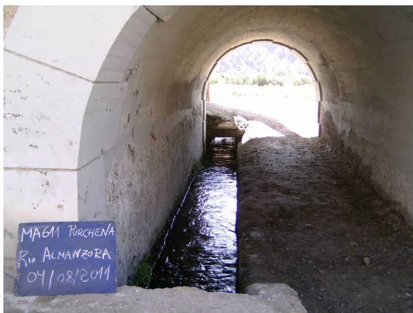
Figura 7. Canal de agua en las proximidades de la estación MA611 (04/08/2011).
