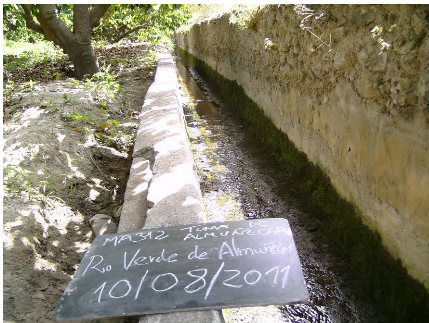
Figura 13. Aspecto del canal del río Verde de Almuñécar (10/08/2011)
