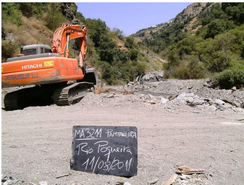
Figura 17. Obras aguas arriba de la estación MA3211 (11/08/2011)
