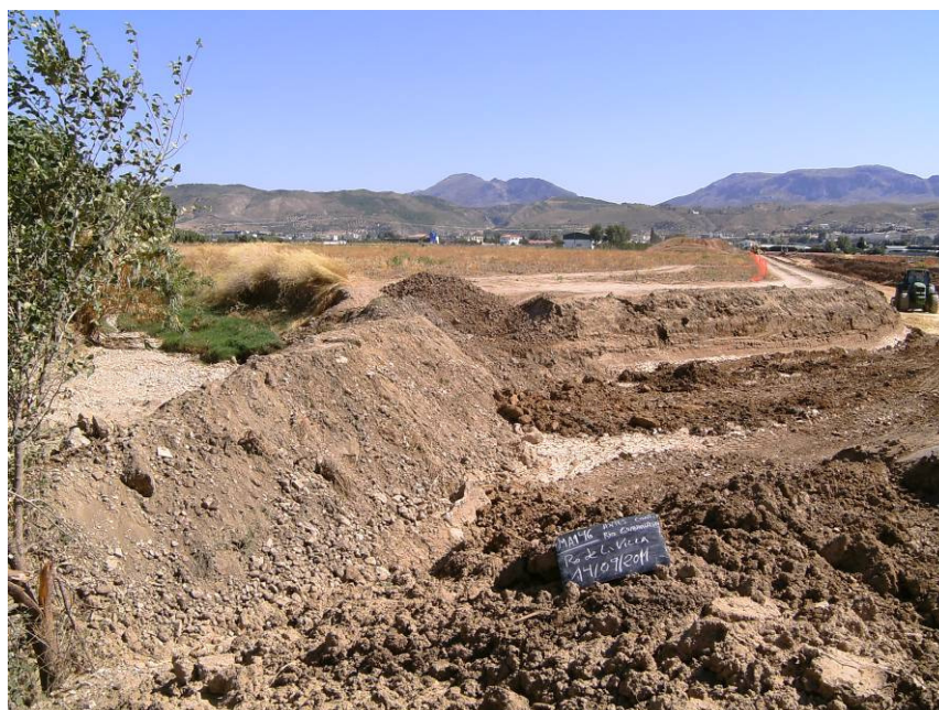
Figura 11. Obras junto al cauce del río de La Villa (14/09/2011)
