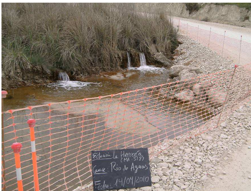
Figura 14. Detalle de la estación de muestreo y carril de acceso a obras (14/04/2010)
