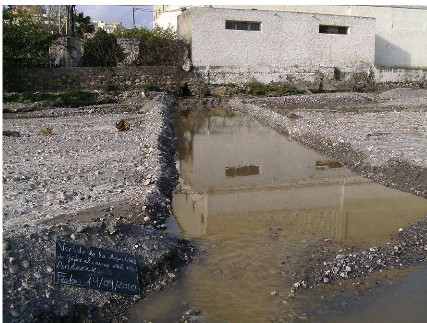
Figura 12. Vertido de aguas residuales de la depuradora de Gádor al río Andarax (14/04/2010)
