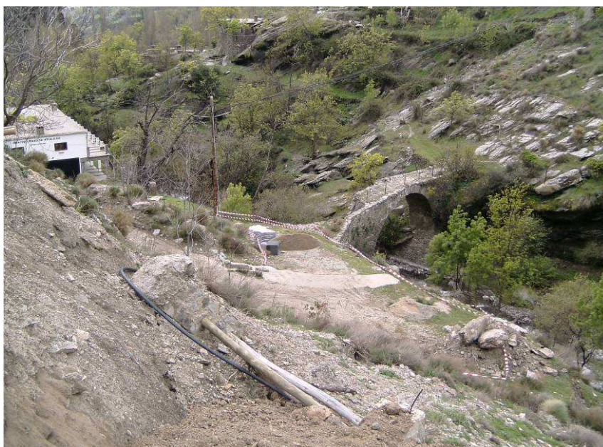
Figura 10. Desprendimiento de ladera y puente romano junto a la estación Ma-051 (13/04/2010)
