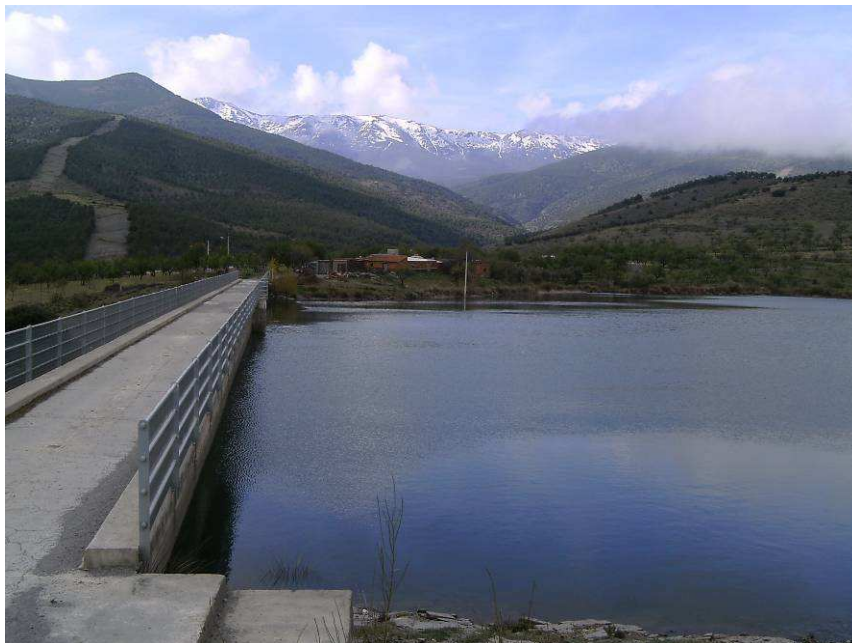
Figura 13. Presa del Castañar en el momento de la toma de muestras (14/04/2010)
