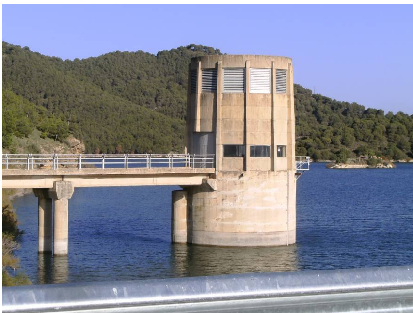
Figura 3. Torre de toma del Embalse de Guadalhorce (09/12/2010).
