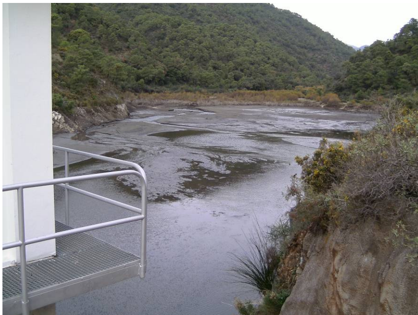
Figura 4. Aspecto de la Presa de Guadaiza en el momento de la toma de muestras (13/12/2010).
