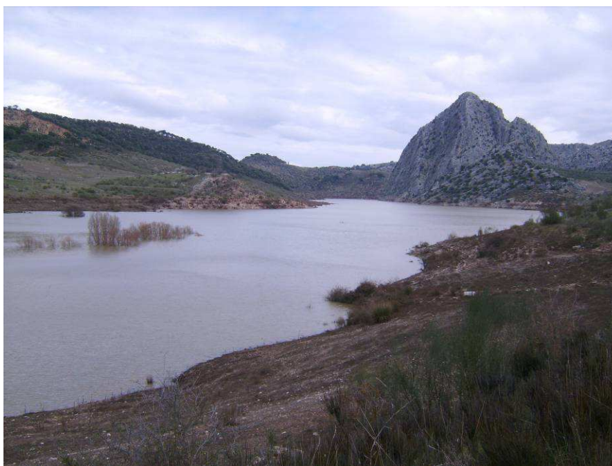
Figura 5. Cola de la Presa de Montejaque (03/02/2010).
