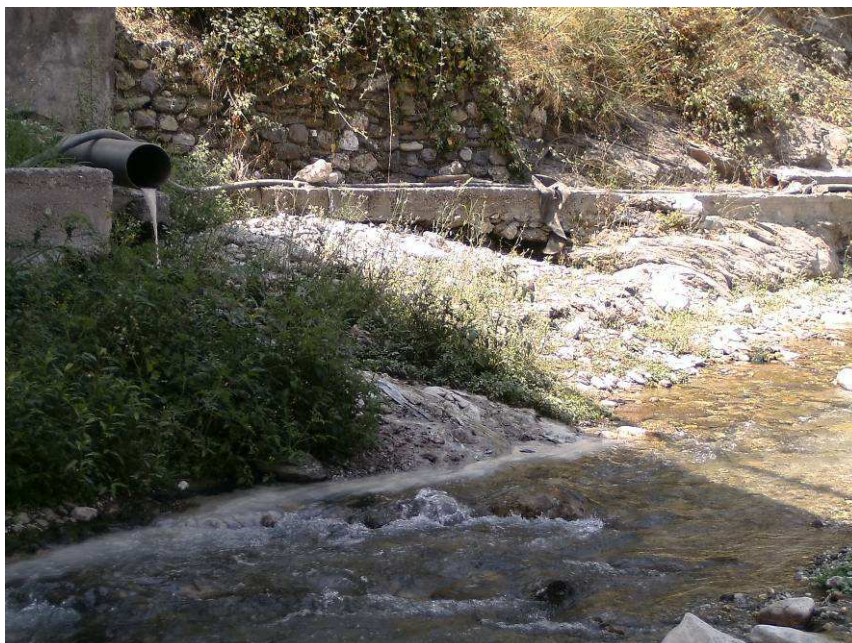
Figura 15. Tubo de vertido de aguas residuales al cauce del río de la Toba (20/07/2010)
