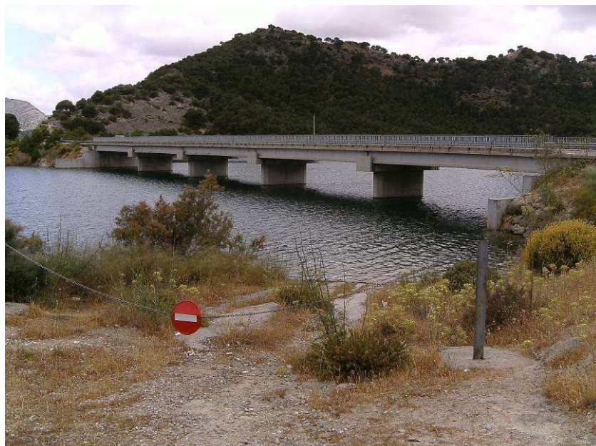
Figura 4. Puente bajo el que se mezclan las aguas embalsadas de Guadalhorce y Guadalteba (03/06/2010).
