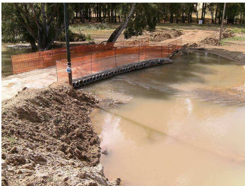
Figura 9. Obras de construcción de un pequeño puente en la MA-019. (10/06/2010).
