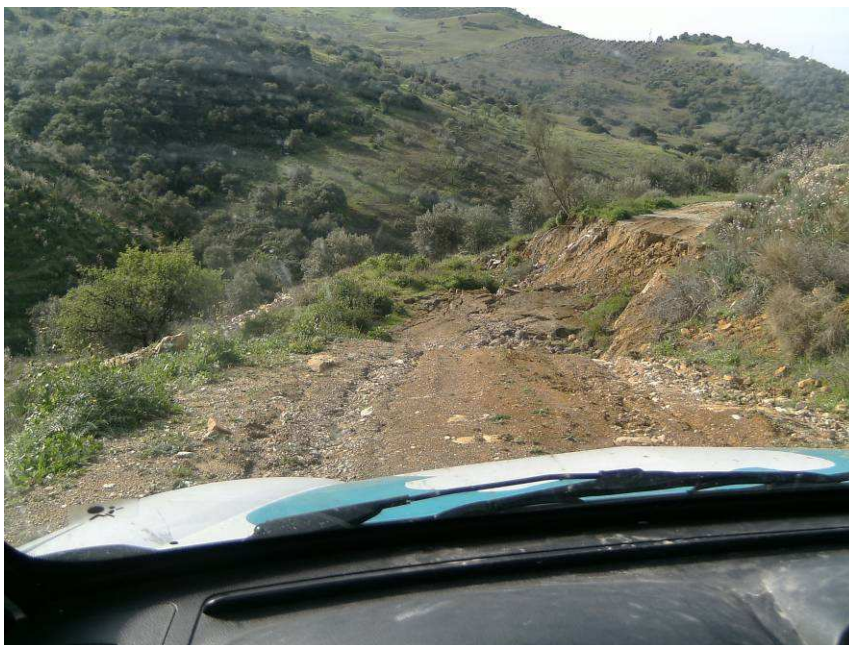
Figura 18. Carril cortado por desprendimientos y deslizamientos del terreno (15/03/2010)
