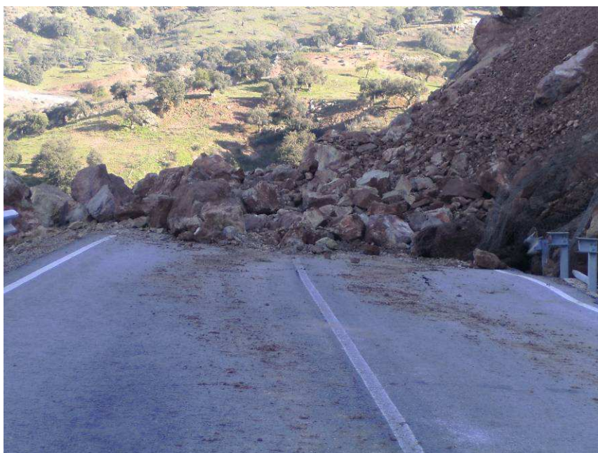
Figura 21. Visual de detalle del desprendimiento que impide llegar a la estación MA-026 (16/03/2010)
