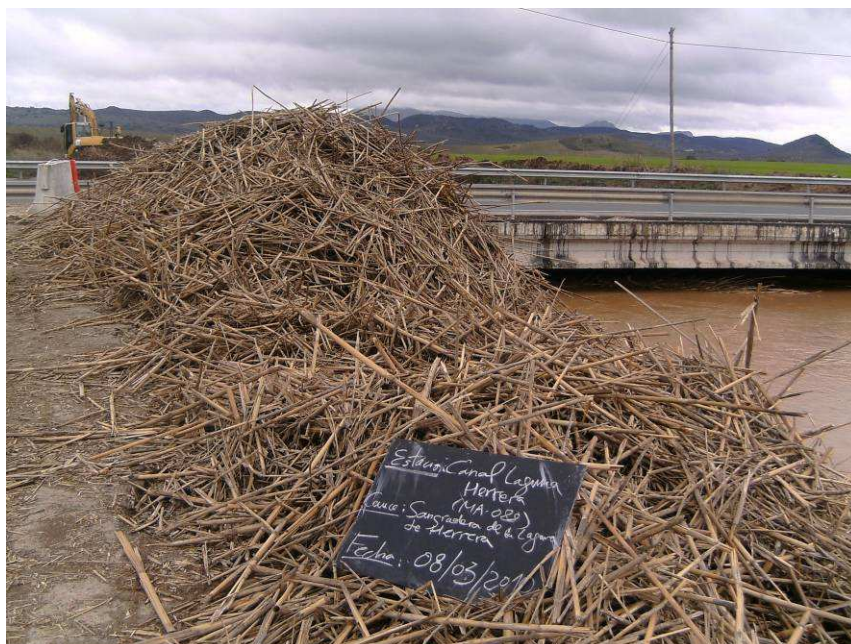
Figura 10. Acúmulo de cañas retiradas en la estación MA-088 (08/03/2010)
