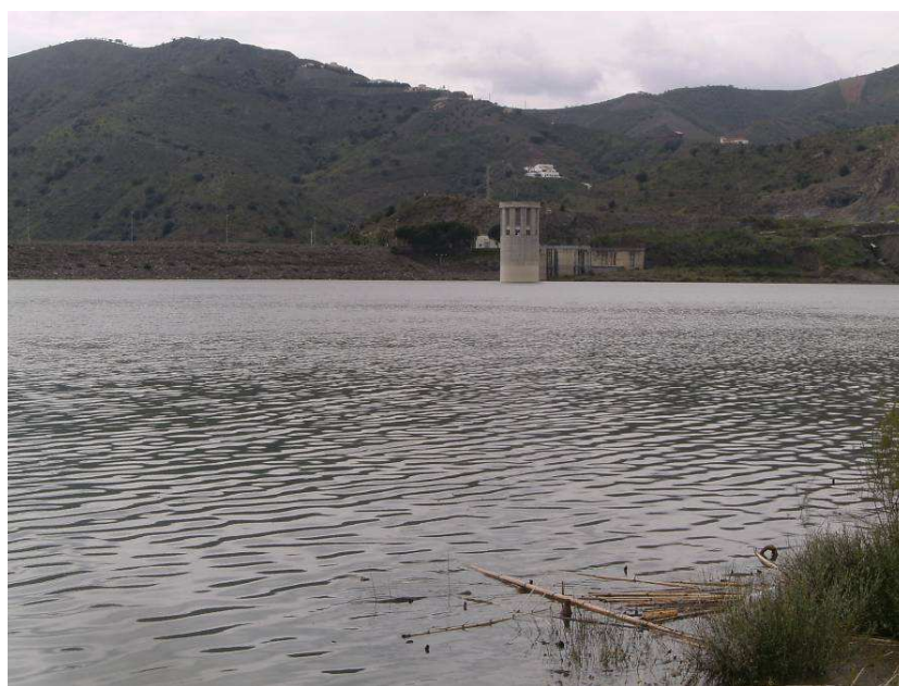
Figura 17. Vista de la torre del embalse de La Viñuela (11/03/2010)
