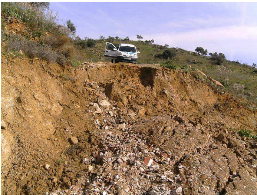
Figura 19. Socavón en el carril que impide llegar en coche a la estación MA-020 (15/03/2010)
