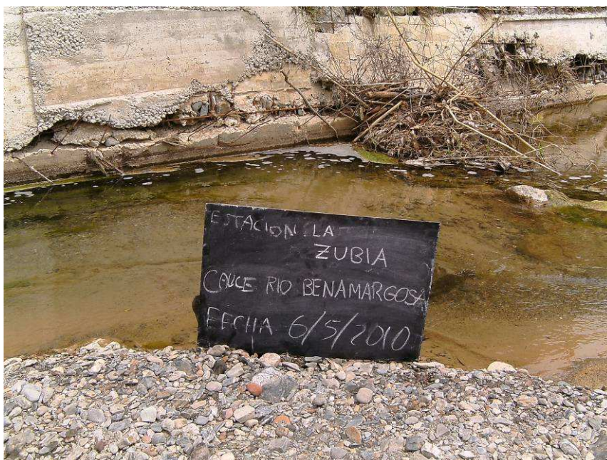
Figura 3. Aspecto del agua en la estación MA-601 (06/05/2010).
