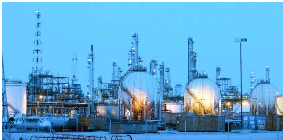
■ Polo químico de Huelva, Palos de la Frontera (Huelva). H. Garrido.
