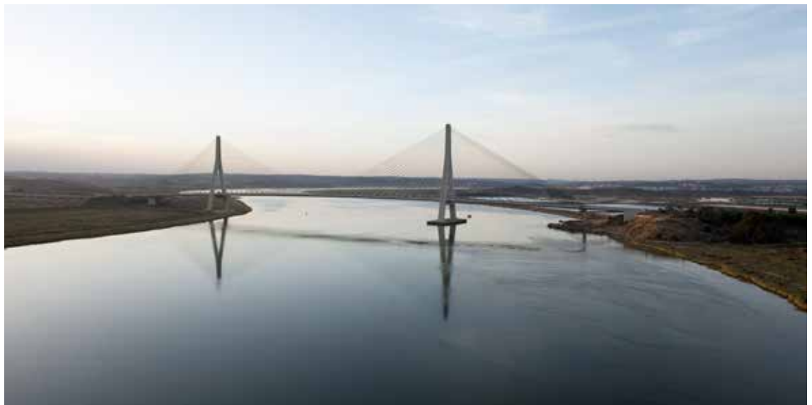
■ Puente Internacional del Guadiana, Ayamonte (Huelva). J. Hernández Gallardo.
