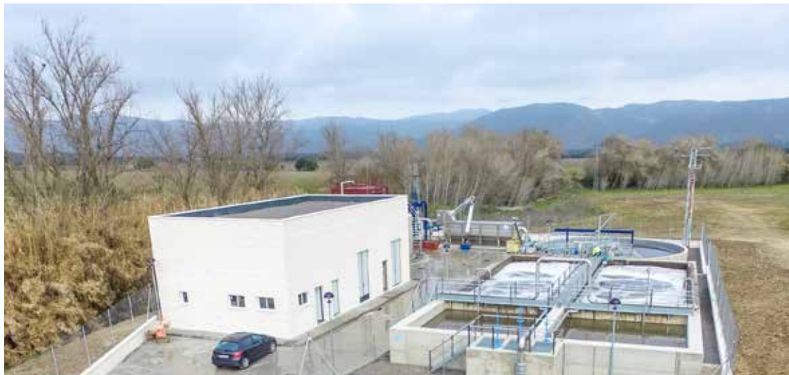
■ Estación depuradora de aguas residuales (EDAR), Aroche (Huelva).
