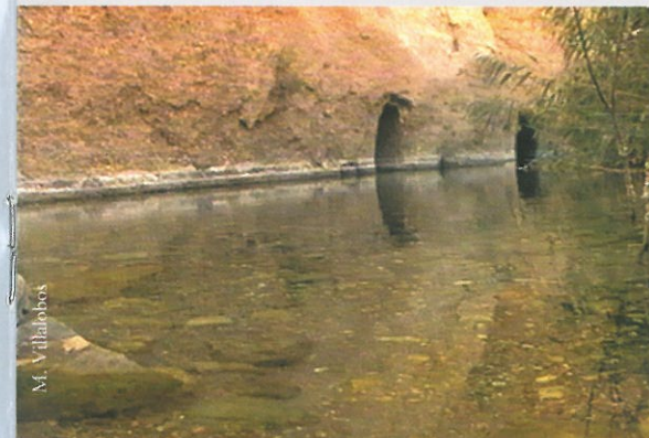
Galerías de captación en los Manantiales de los Molinos del Río Aguas
