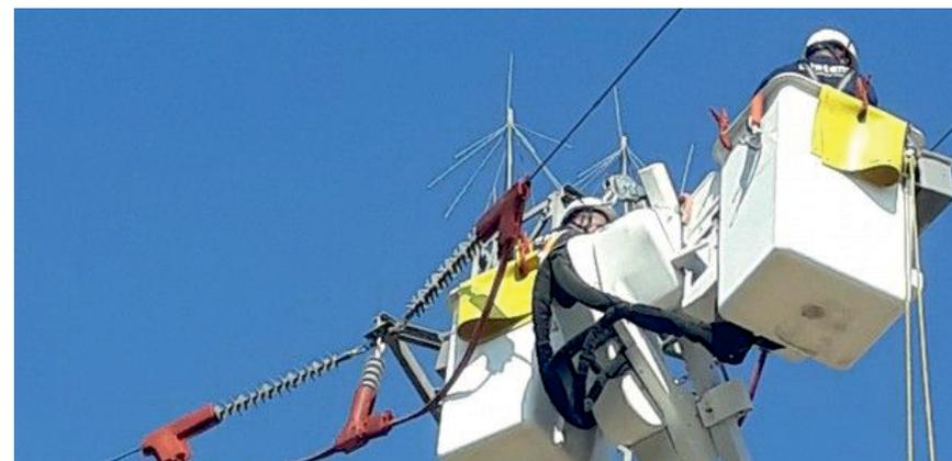
Colocación de dispositivo antielectrocución (JA)
