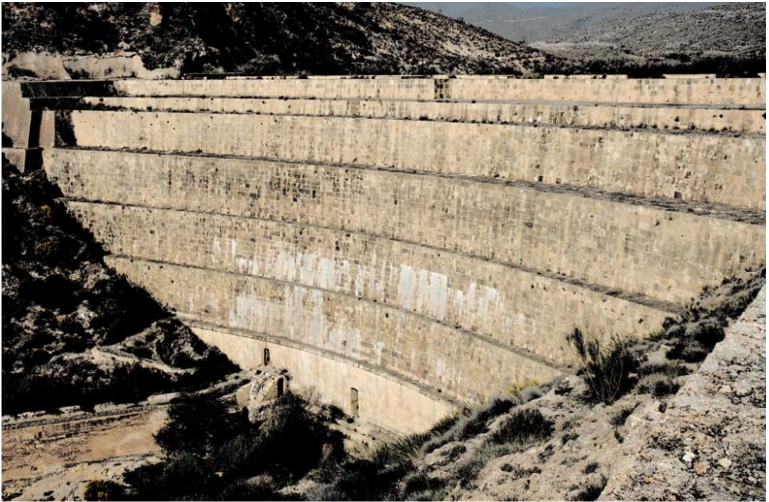
Muro escalonado aguas abajo de la presa de Isabel II de Níjar (Almería). (E. LÓPEZ)
