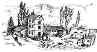
Conjunto de la Fábrica de Tejidos de Víznar. (F. GONZÁLEZ ARROYO)
