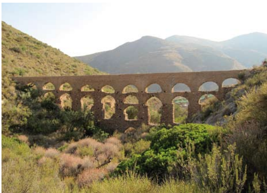
Acueducto de los Veinte Ojos del sistema hidráulico de la rambla de Carcauz.
