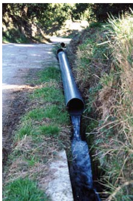
Tubo de riego colocado para reemplazar un tramo de una acequia en Murchas. (J. R. GUZMÁN)
