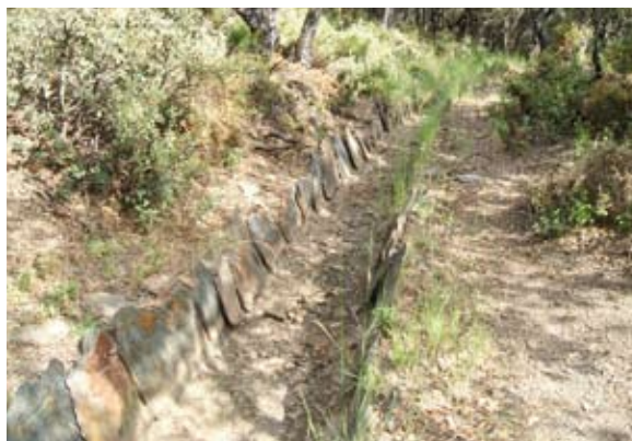
Trayecto de la acequia del Monte de Laroles con piedras liseras. (J. C. ÁVILA)
