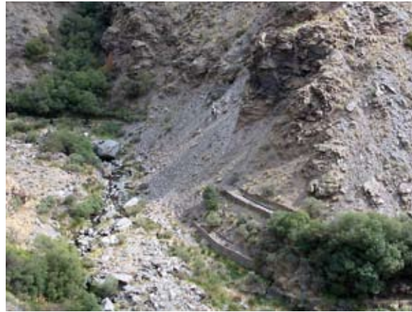
Deslizamiento de tierra sobre una acequia, que queda obstruida, en el barranco del río Poqueira, en la Alpujarra de Granada. (J. R. GUZMÁN)
