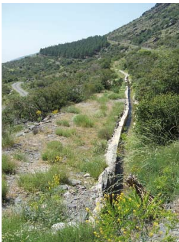
Acequia del Boe con refuerzo de hormigón, Laroles (Granada). (J. C. ÁVILA)
