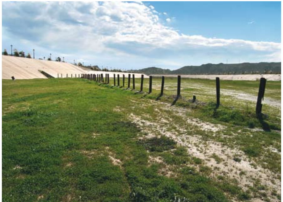
Estructura de presa y boquera en un tramo ya encauzado del río Almanzora. (J. M. García)
