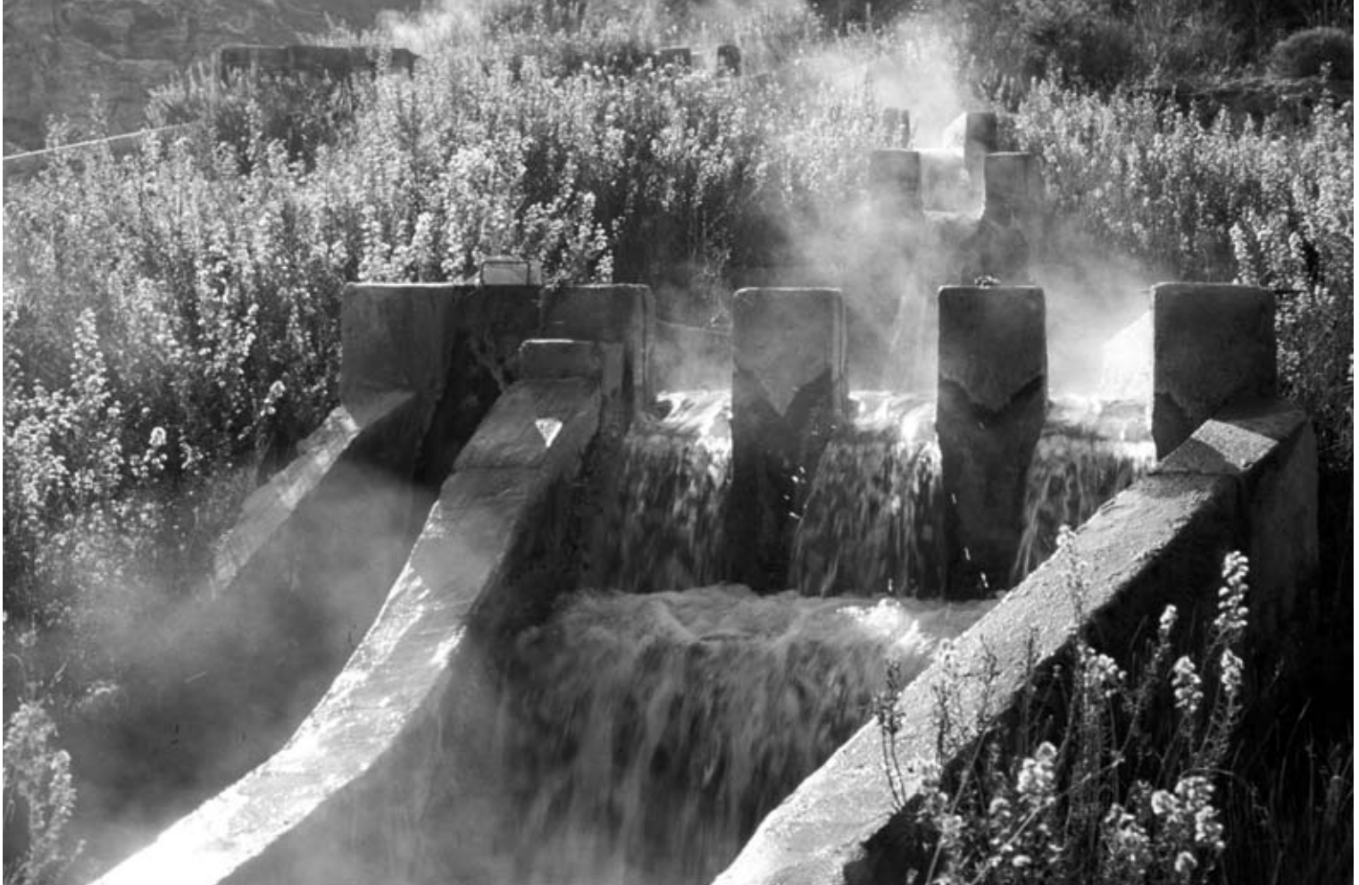
Salto y compuertas de una acequia en Alhama de Almería. (E. LÓPEZ)
