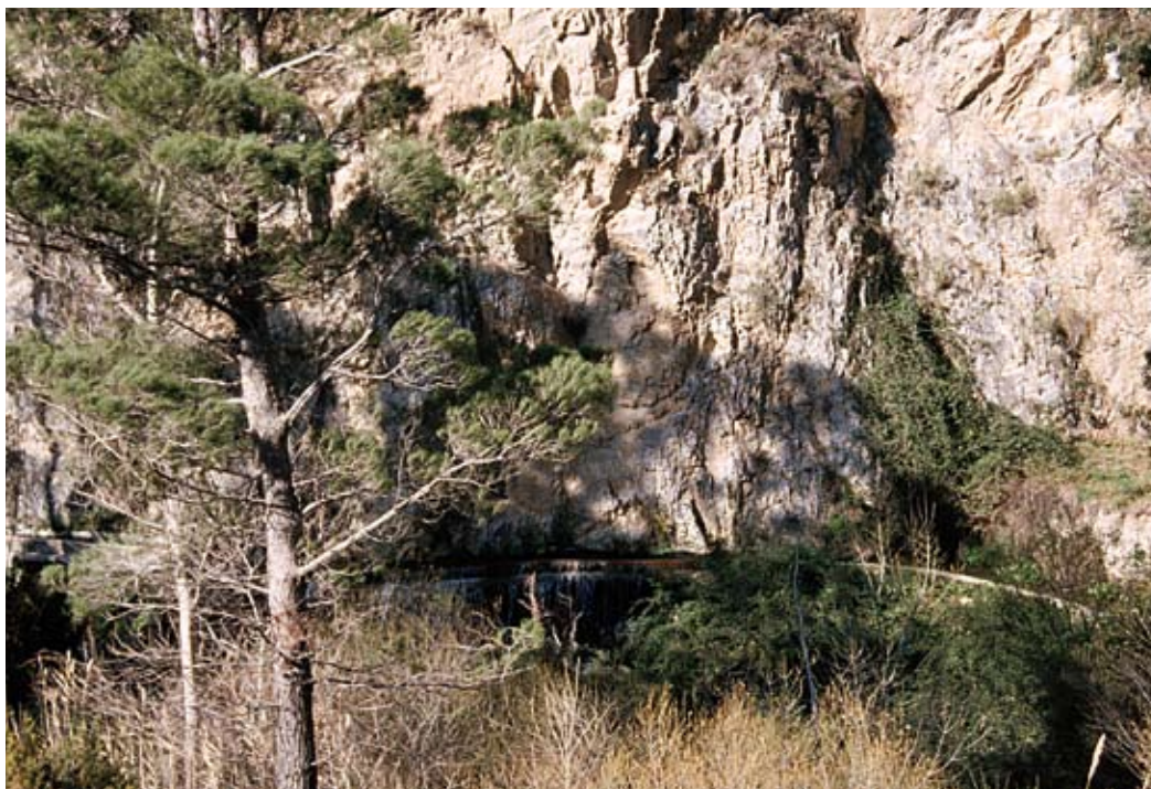
Tramo de la acequia de Los Arcos, en Cónchar (Granada). (J. R. GUZMÁN)
