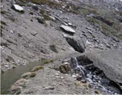
Rebosadero en una acequia de careo de Sierra Nevada.
