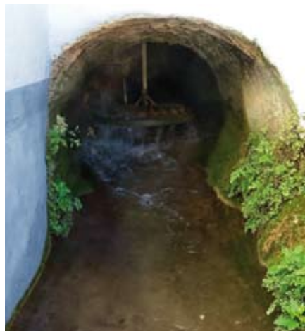
Rodezo en funcionamiento e interior de uno de los molinos hidráulicos tradicionales de Salitre, en el término de Algatocín (Málaga). (J. MORÓN)
