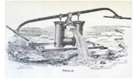
Cigüeña, noria de sangre y bomba manual, ilustraciones de ingenios para la elevación de agua de la obra Arte de la explotación del agua , de Antonio Montenegro, Madrid, 1894. (J. M.ª FERNÁNDEZ-PALACIOS)
