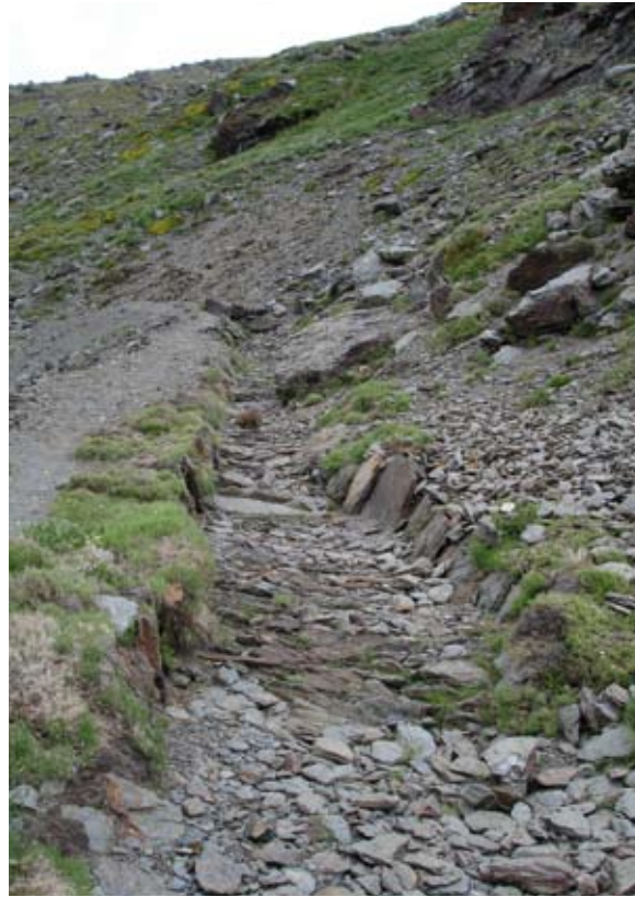
Detalle de la solera empedrada y los cajeros con lajas de una acequia de careo. (E. ORTIZ)
