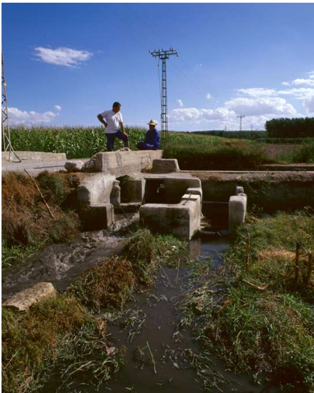
Sistema de distribución de las aguas de una acequia en la Vega de Granada. (J. MORÓN)
