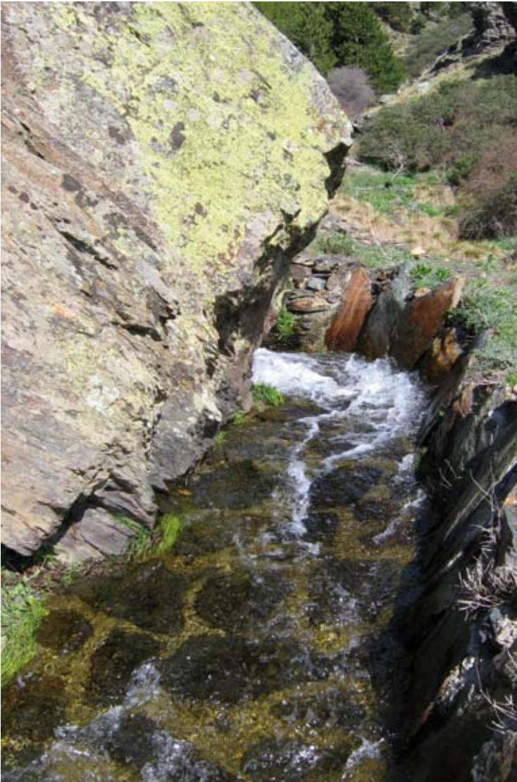
Acequia con lajas rehabilitada, Válor (Granada). (P. PLAZA)
