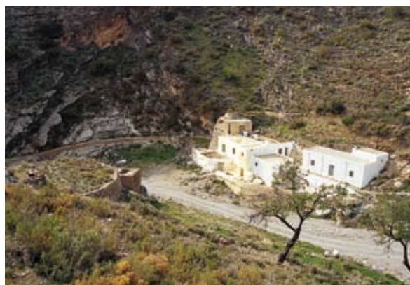
Molino hidráulico de Luis Faba, en Felix (Almería), con el caz, el cubo y la acequia de salida de las aguas, asociado al dispositivo de la rambla de Carcauz.
