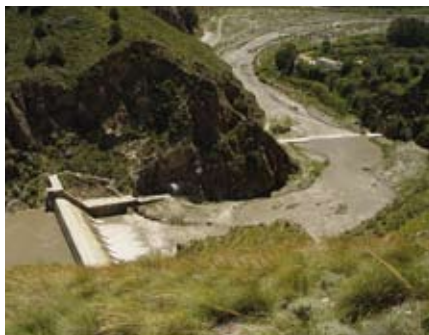
El llamado Dique del Granadino, en las cercanías de la junta de los ríos Poqueira y Trevélez que descenden por la cara meridional de Sierra Nevada. (AGENCIA ANDALUZA DEL AGUA)
