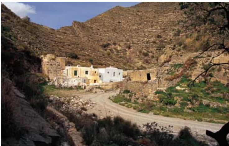
Paraje del Rincón del Molino, sobre la rambla de Carcauz, con las acequias y otros dispositivos hidráulicos del molino de Luis Faba, en la Sierra de Gádor (Almería).
