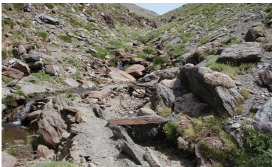
Toma de una acequia de careo en el área de cumbres de Sierra Nevada. (E. ORTIZ)
