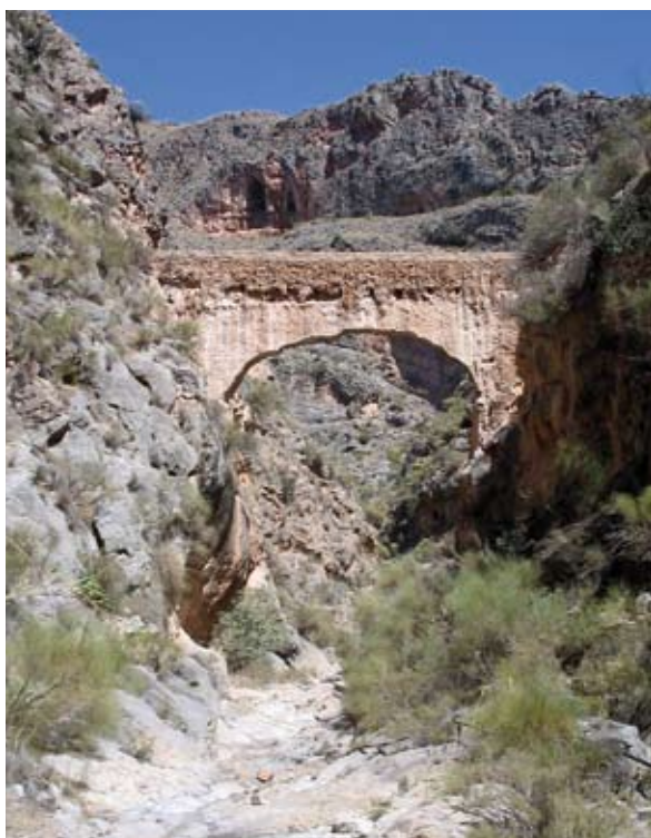
Puente de los Poyos, sobre la rambla de Carcauz. (J. R. GUZMÁN)
