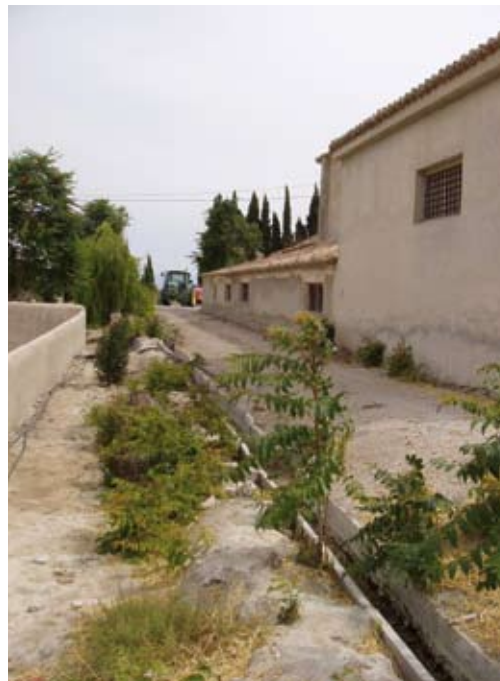
Paso del Caz Mayor a lo largo de las antiguas edificaciones de la Colonia, en la hoya de Baza (Granada). (C. COBO)
