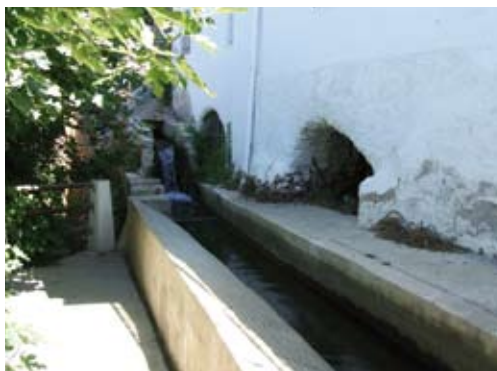
Acequia cuyo caudal se empleaba para la triple función del riego, un molino hidráulico y un lavadero, en Laroles (Granada). (I. C. ÁVILA)
