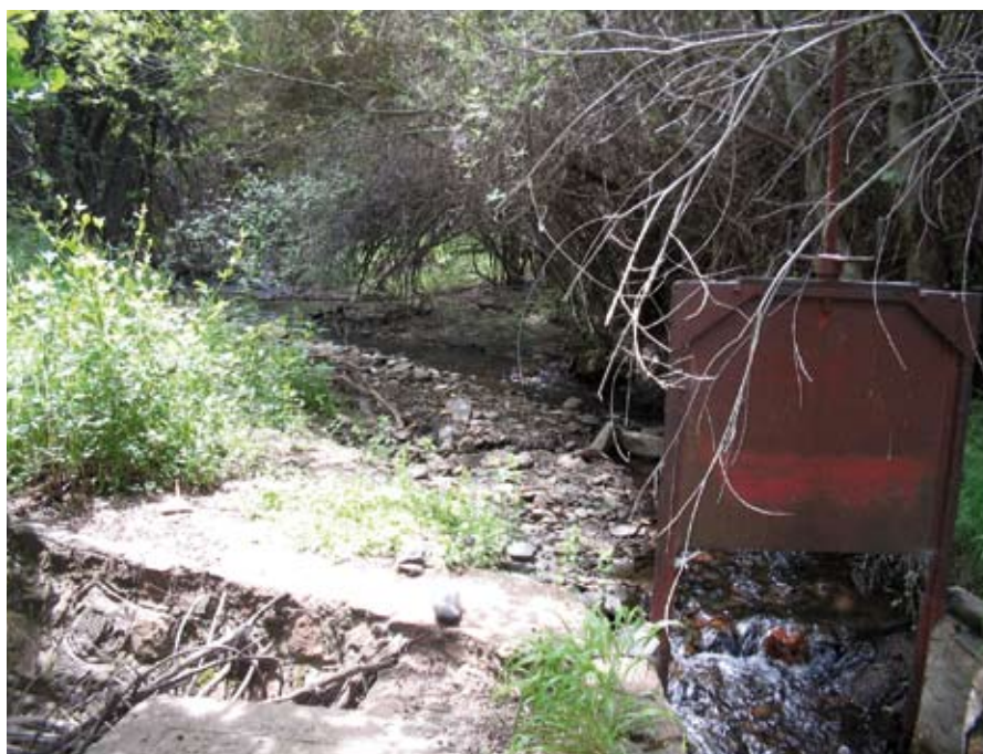
Compuerta de toma de agua para una acequia de Huéneja (Granada). (J. R. GUZMÁN)
