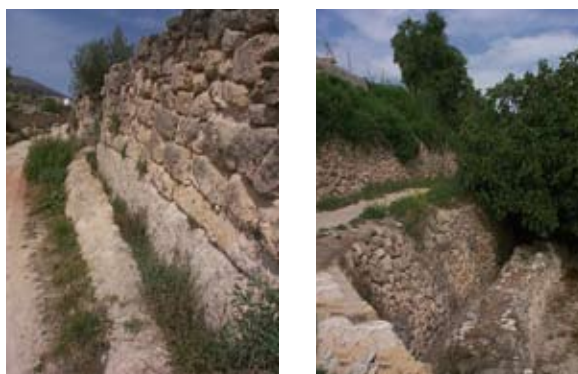
Ejemplos de la red de distribución de agua para riego de la Huerta de Pegalajar (Jaén). (R. Vioque)
