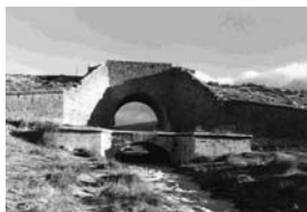
Puente de las Ánimas, una de las obras asociadas a la construcción del Canal de Carlos III. (J. Díaz)
