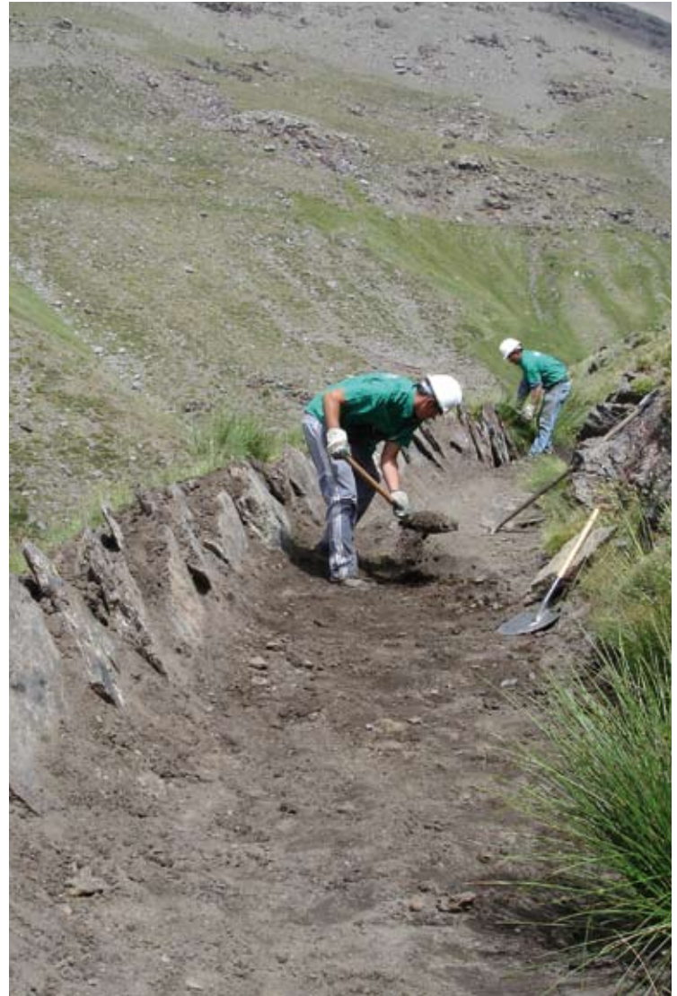
Trabajos de rehabilitación de una acequia de careo en Sierra Nevada. (E. ORTIZ)
