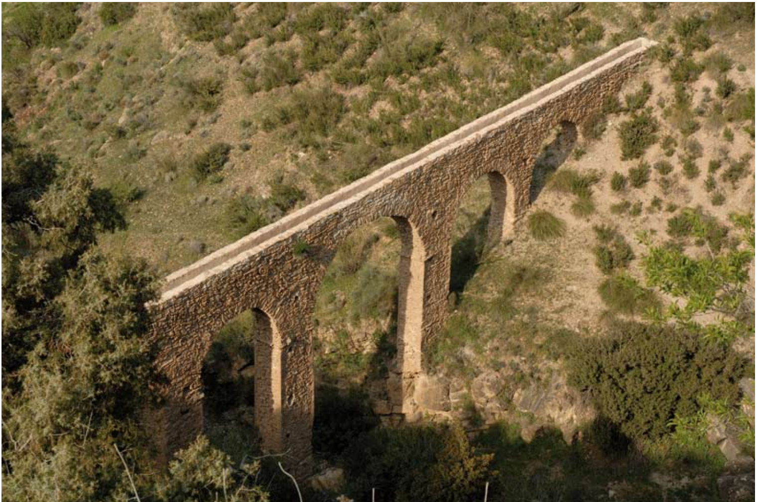
Acueducto de posible origen romano vinculado al riego, en el término de Albánchez (Almería). (E. LÓPEZ)
