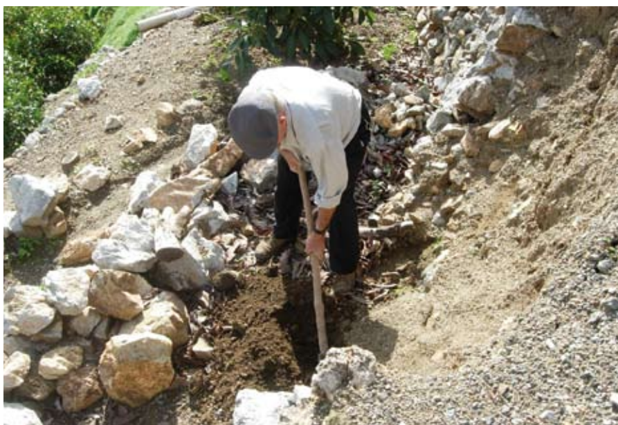
Trabajando las paredes de piedra de los bancales, Río Grande, Yunquera.
