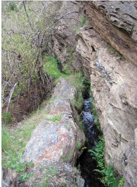
Tramo de la acequia de Válor (Granada) encajado en la roca. (P. PLAZA)
