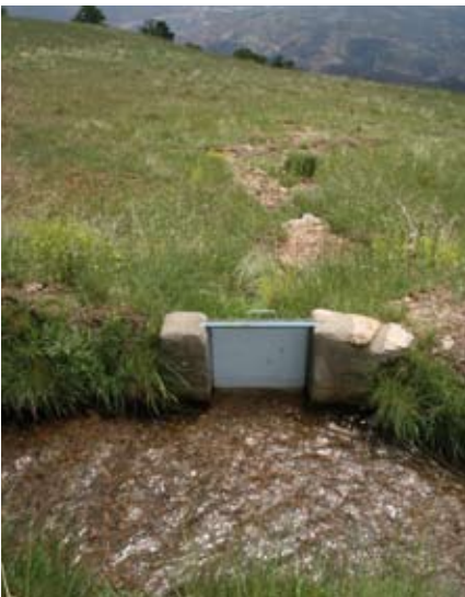
Compuerta para carear agua de una acequia de Lanjarón (Granada). (J. R. GUZMÁN)
