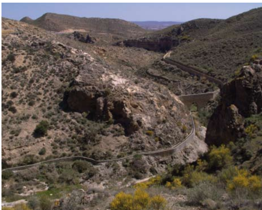
Canal del dispositivo de la presa de Isabel II de Níjar. (G. MONTOVA)
