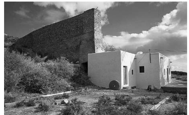
Caz, cubo y casilla de un molino harinero hidráulico de Huebro, Níjar (Almería).
