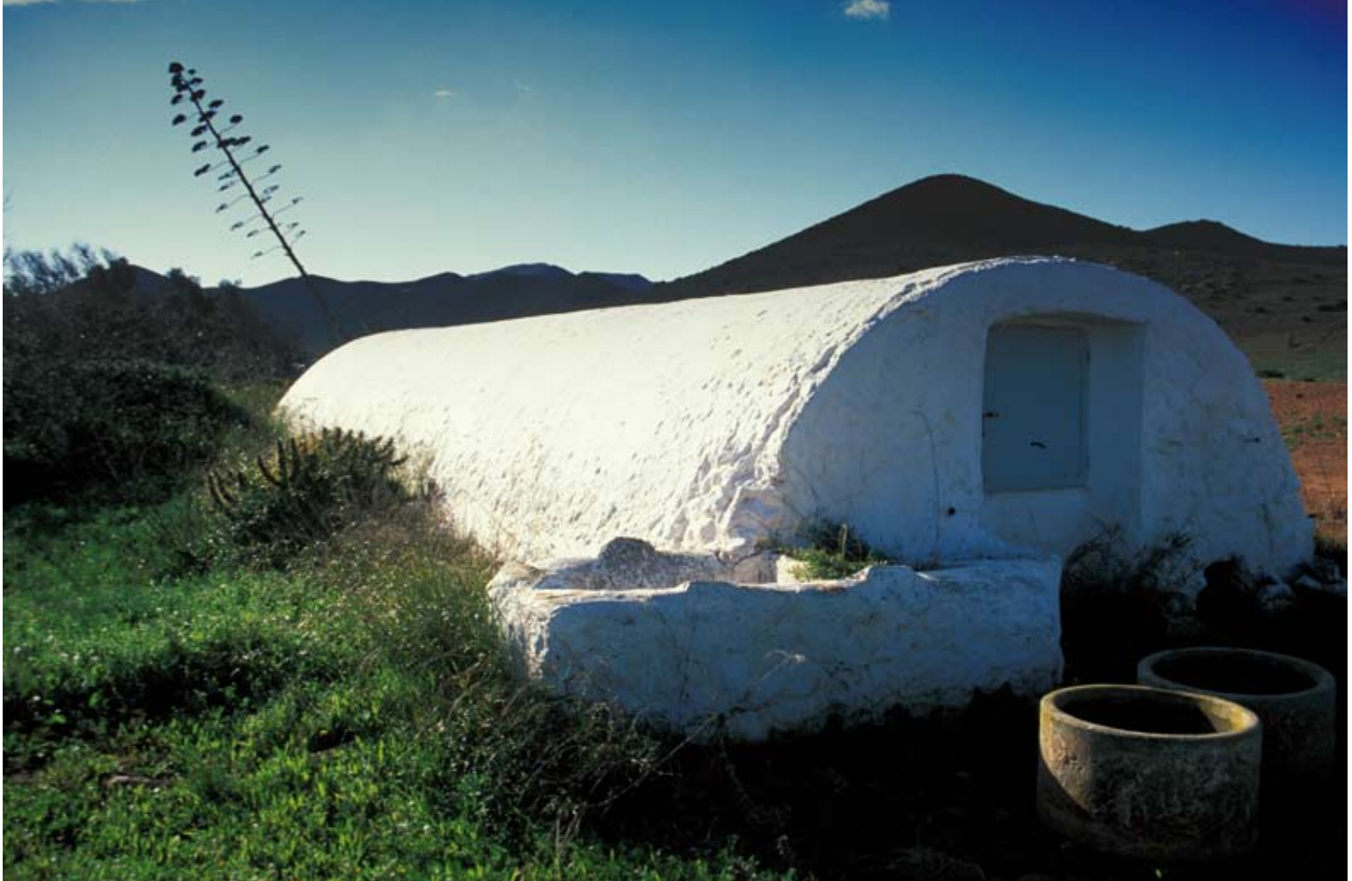
Aljibe cerrado con bóveda de cañón en San José, Níjar (Almería). (E. LÓPEZ)
