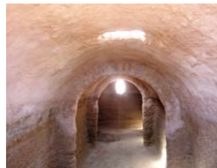
Bóveda interior del Aljibe Bermejo, de orígenes romanos, en Níjar (Almería). (I. BESTUE)
