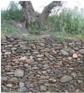
Muro en piedra seca de un bancal, Abrucena (Almería). (J. R. GUZMÁN)
