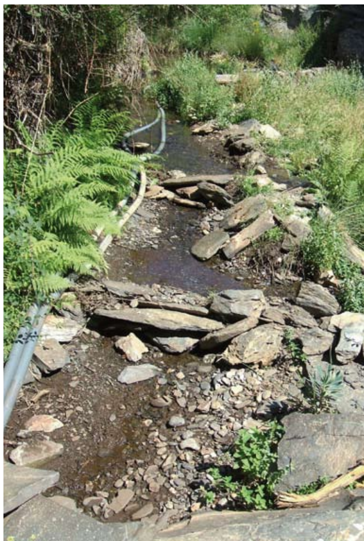
Represa y tuberías en la acequia del Monte, en el término de Laroles (Granada). (I.C. ÁVILA)
