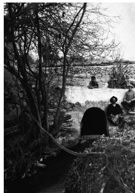
Salida o bocamina de una galería de captación en Cuevas del Almanzora (Almería), en una imagen tomada por J. Ballestrín hacia 1925. (COLECCIÓN JUAN PARRA / E. FERNÁNDEZ BOLEA)
