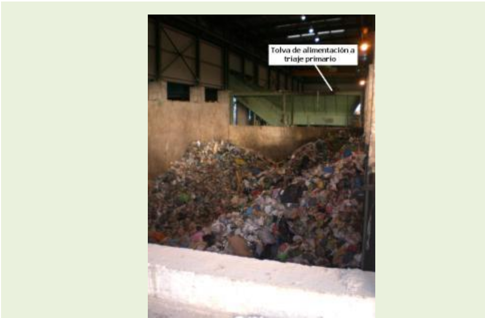
Fotografías nº 74: Foso de recepción
