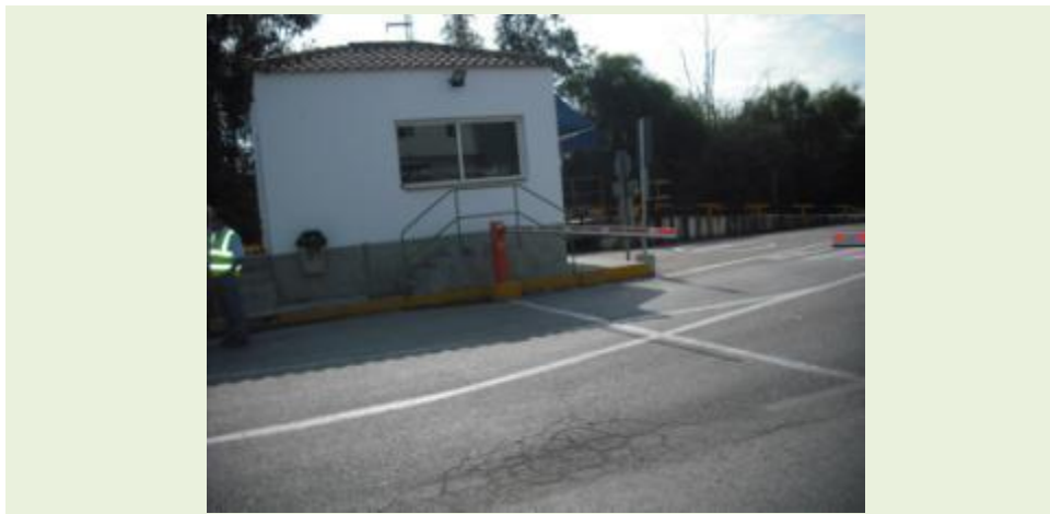
Fotografía nº 60 Edificio de control de acceso a las instalaciones
