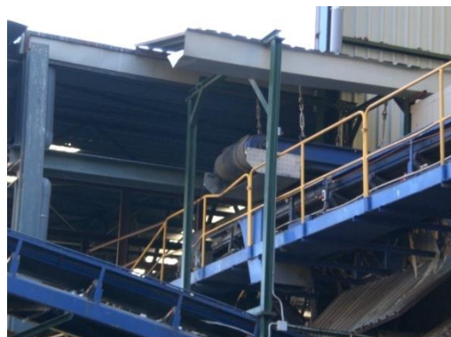
Fotografías nº 39 Separador magnético de la línea de orgánicos
