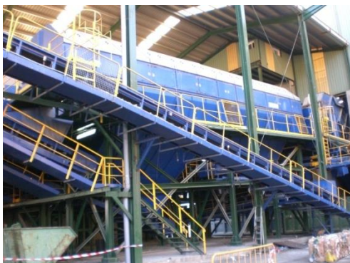
Fotografías nº 38 Vista de la etapa de recuperación
