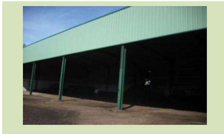
Fotografía nº 5. Zona de maduración
