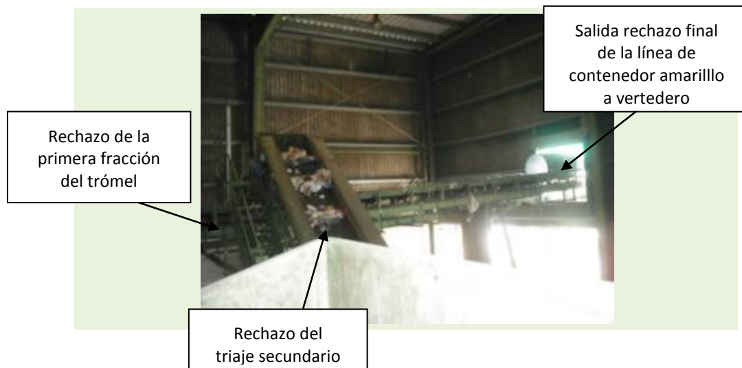
Fotografías n° 56 Unión del rechazo del triaje secundario y primer hundido del trómel (fracción de < 80 mm)
