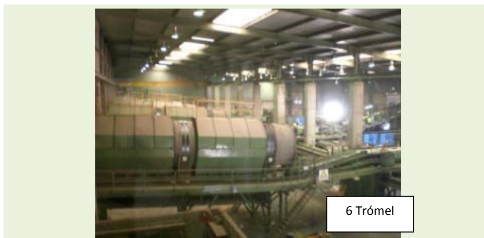
Fotografías nº 62 Vista de la zona de recuperación
