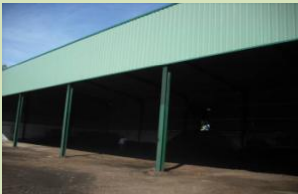
Fotografía nº 5. Zona de maduración
