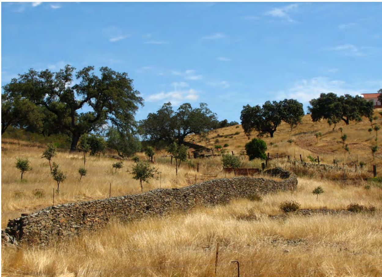
Foto 5: Muro de piedra tradicional levantado con pizarra. Villanueva de las Cruces, Huelva.
