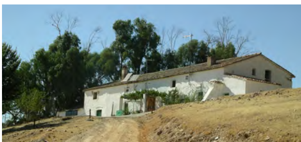
Foto 24. Cortijo de Carnicera (Santiesteban del Puerto).
