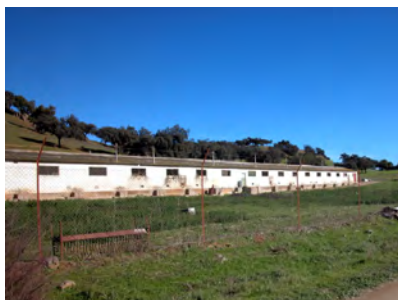
Foto 10: Nuevas construcciones agropecuarias en el medio rural.
