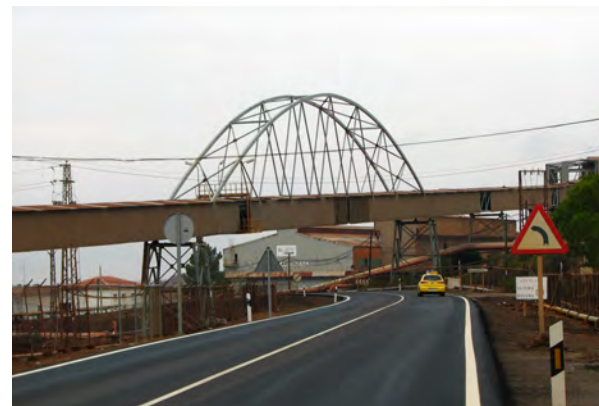
Foto 11: Estructuras metálicas abandonadas de las antiguas minas de Riotinto.
