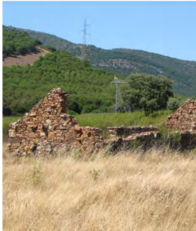
Foto 1: Antigua construcción levantada con materiales autóctonos. Al fondo, bosque de pinos de repoblación. Andújar, Jaén. Autor: Antonio Ramírez Ramírez.
