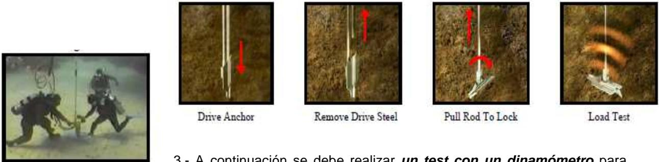
3.- A continuación se debe realizar **un test con un dinamómetro** para estabilizar el sistema de anclaje con la idea de encontrar la posición adecuada del ancla para que su empotramiento en el terreno sea el adecuado. El esfuerzo que se debe soportar máximo, será de 178 KN, con un factor de seguridad de 2. Se adjunta una tabla de capacidades de anclaje y tipo de anclaje, en función de la calidad de fondo:
