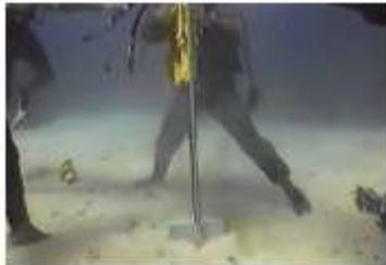
cuerpos metálicos se cierran para permitir el empotramiento del sistema de anclaje. Al aparecer la tensión de la embarcación, dichas aletas se "abren" dentro del fondo marino, impidiendo la salida del sistema de anclaje ejerciendo un empotramiento perfecto. A continuación, se describe sus características geométricas y técnicas del sistema MR-
