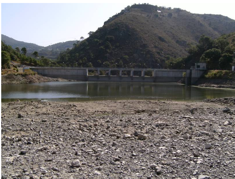
Figura 13. Presa de Guadalmina (13/08/2009).
