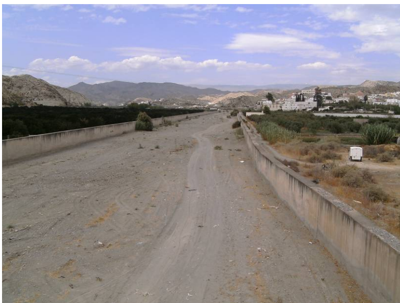
Figura 23. Vista del cauce del río Nacimiento, a la derecha la población de Alhabia (25/08/2009)
