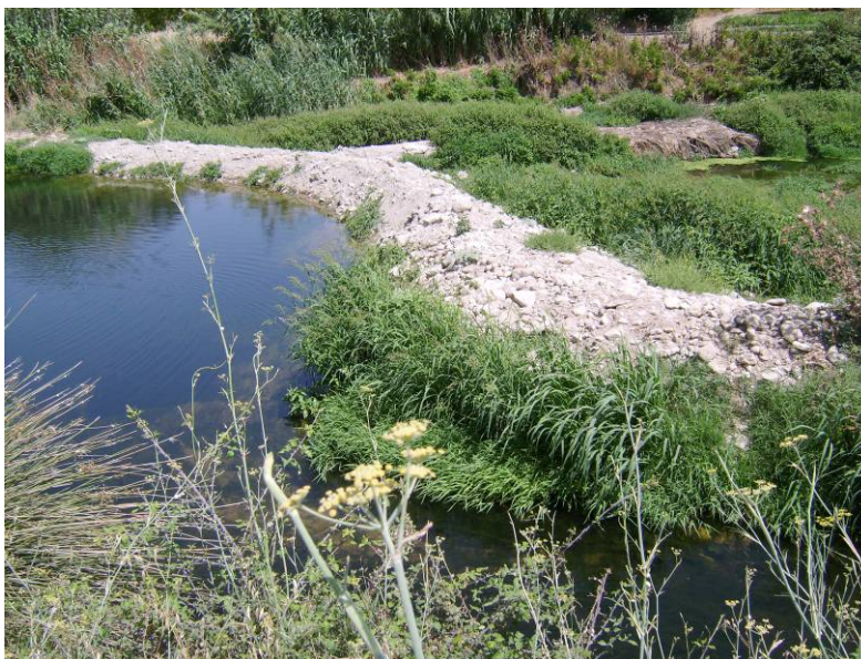
Figura 2. Desvío del caudal mediante un azud de piedras y tierra en el cauce del río Guadiaro (6/08/2009).
