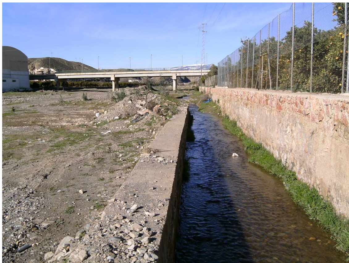
Figura 6. Encauzamiento del río Andarax por canal anexo en su margen izquierda a la altura de la estación MA101 (14/01/2009)
