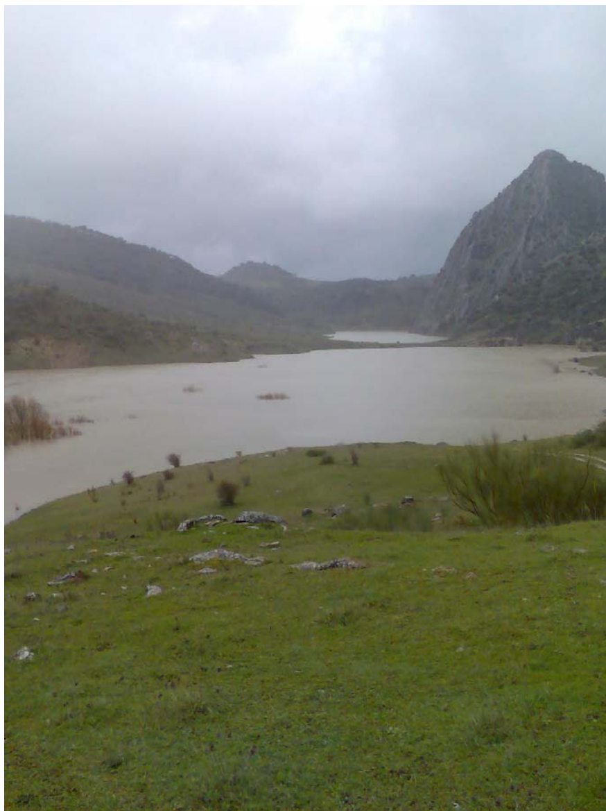
Figura 6. Cola de la Presa de Montejaque en el momento de la toma de muestras (04/02/2009)
