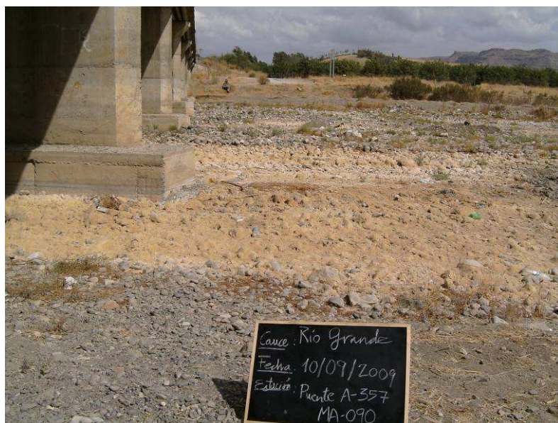
Figura 6. Cauce de río Grande en el puente de la A-357 (10/09/2009)
