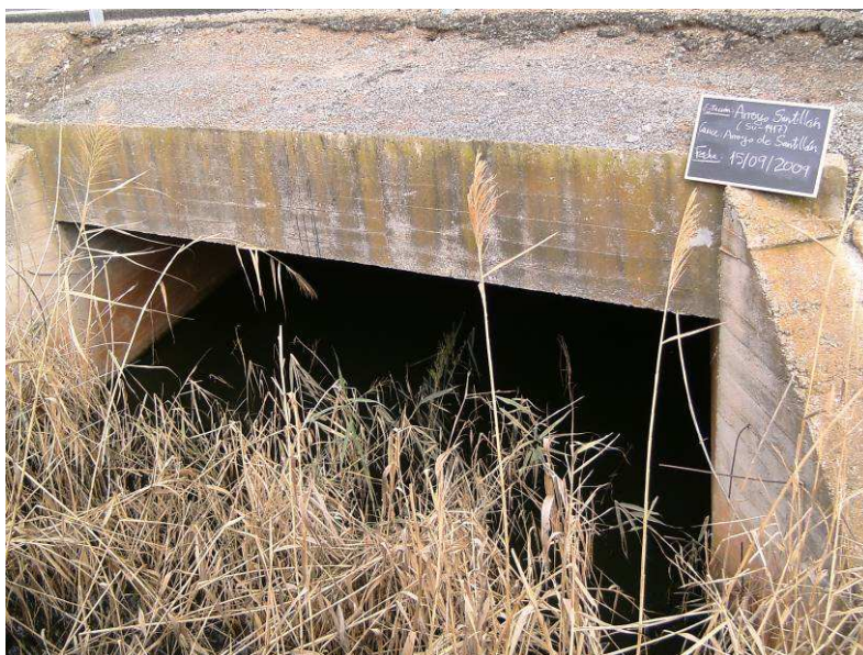
Figura 9. Agua estancada en la estación de muestreo SU-1417 (15/09/2009)
