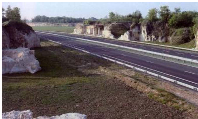
Figura 5 y 6. Bernard Lassus, aire de Nîmes-Cassaugues sobre la autopista A 54, vista general del lugar.
