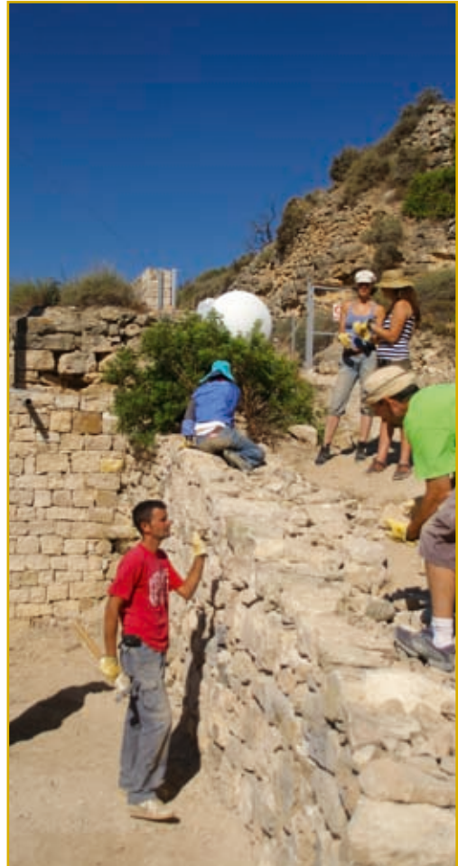
Muro de contención en La Fatarella
