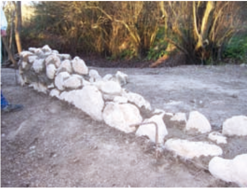
Delimitación mediante hilo albañil y piqueta
