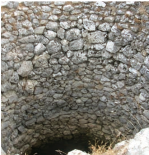
Pozo con protección
