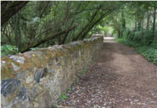
Muro. Rivera del Huéznar (Sevilla)
