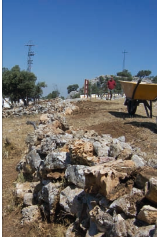
Muro a una línea
