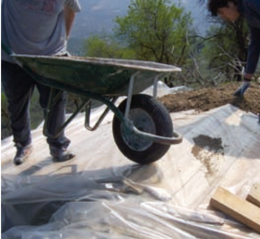
Impermeabilizar la cubierta
