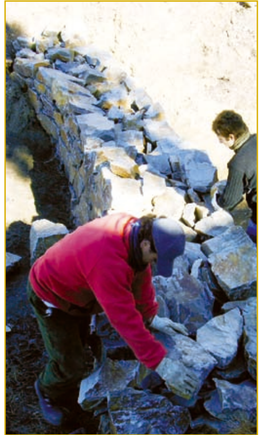
Vista construcción albarrada
