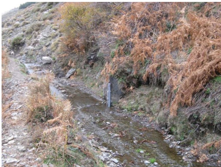
Registrador de nivel capacitivo instalado en acequia
