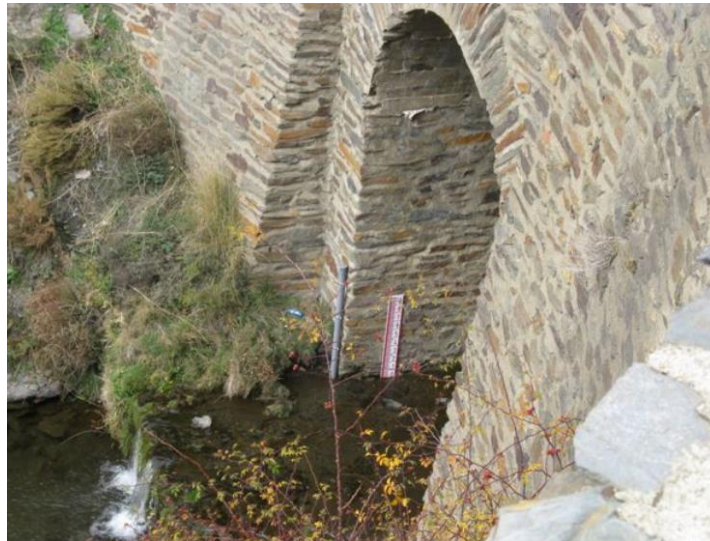
Registrador de nivel capacitivo instalado en cauce natural con escala limnimétrica
