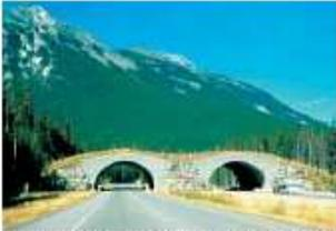
Figura 1.3 – Bóvedas que permitieron la construcción del ecoducto con la vía en funcionamiento. Foto: H. Bekkat
