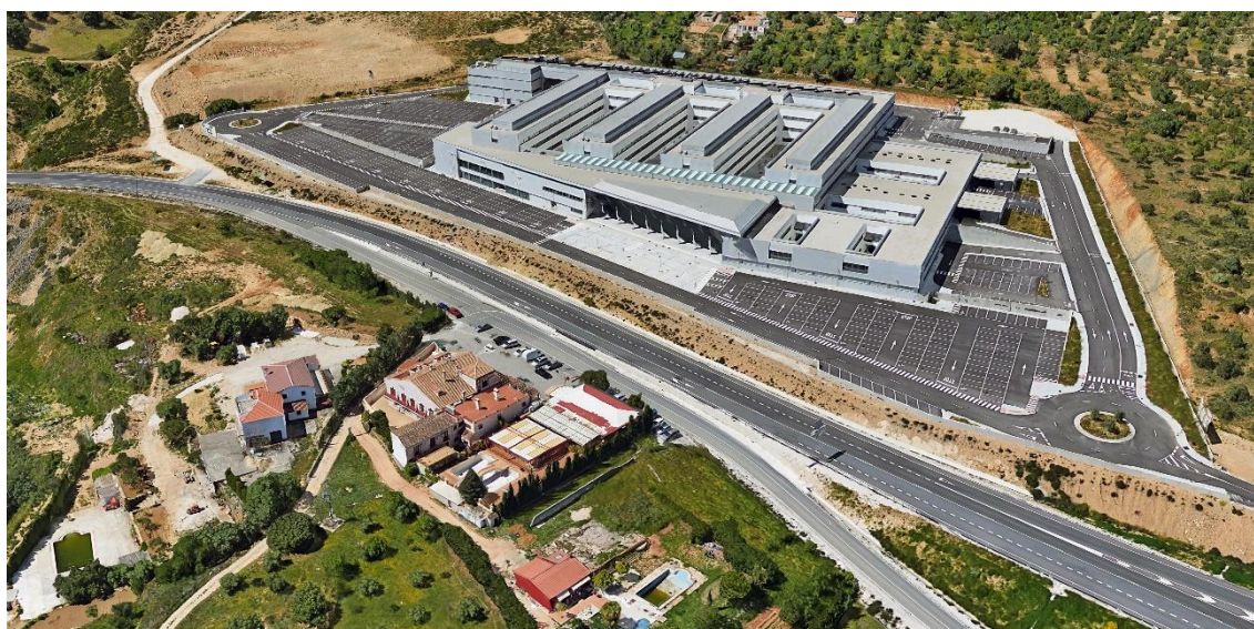
Vista aérea del Hospital de la Serranía de Ronda
