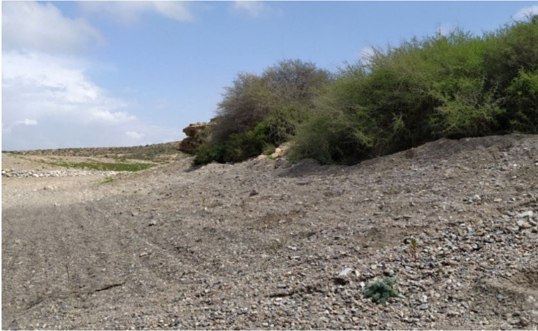
Foto 25. Resultado de de una de las actuaciones realizadas en el marco del servicio de limpieza y acondicionamiento de cauces provincia de Almería 2019-2021 en el espacio ES6110006 Ramblas de Gérgal, Tabernas y Sur de Sierra Alhamilla.
