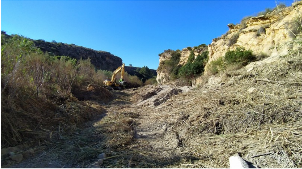
Foto 28. Trabajos de desbroce en el río Aguas realizados en ejecución del proyecto de actuaciones de restauración hidrogeomorfológica y naturalización del río Aguas desde la pedanía de Los Giles hasta su desembocadura (tt.mm. Turre, Los Gallardos y Mojácar), en el espacio ES6110005 Sierra de Cabrera-Bédar.
