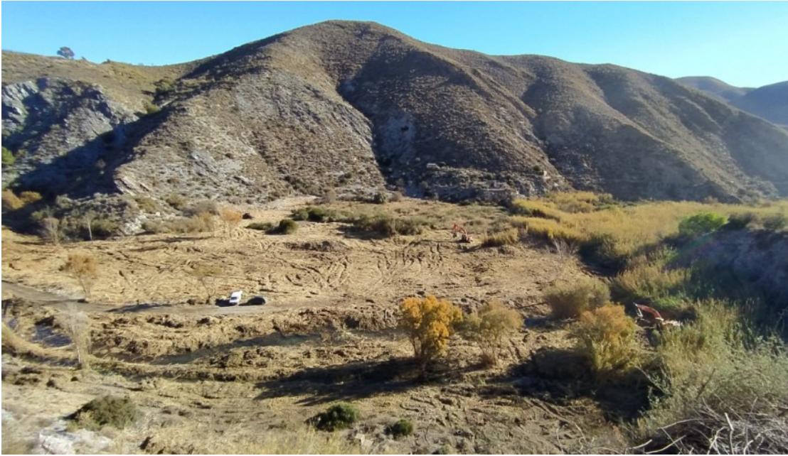
Foto 27. Vista general de un tramo del río Adra en el que se aprecian los trabajos de limpieza del cauce y de desarraigo de cañaverales llevados a cabo en el marco del proyecto de restauración hidrogeomorfológica y naturalización del río Adra Fase II: Tramo aguas arriba de la confluencia de los ríos Grande y Chico (Almería), en el espacio ES6110018 Río Adra.
