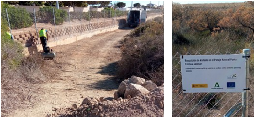
Foto 17. Detalle de un tramo del vallado perimetral instalado en el espacio ES0000048 Punta Entinas-Sabinar.
