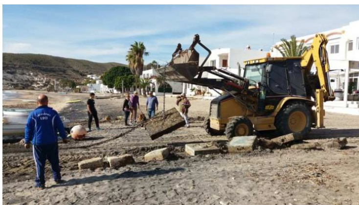
Foto 3.4. Retirada de los muertos con retroexcavadora (20/12/2017).
