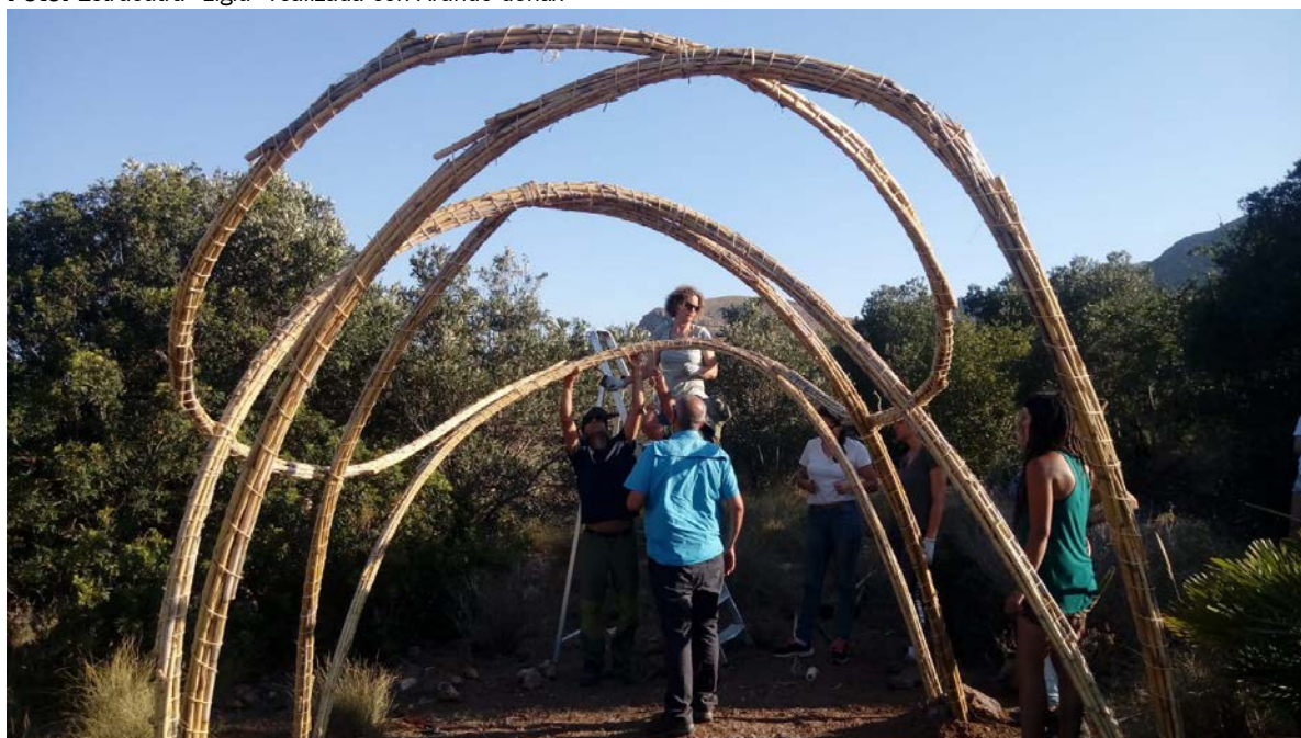
Foto: Estructura "ziglú" realizada con Arundo donax
