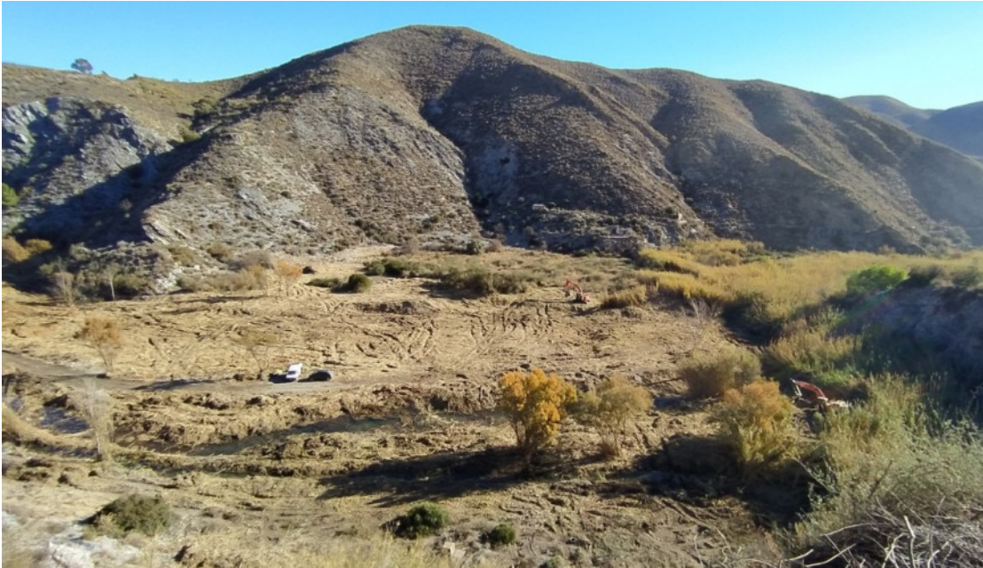
Foto 27. Vista general de un tramo del río Adra en el que se aprecian los trabajos de limpieza del cauce y de desarraigo de cañaverales llevados a cabo en el marco del proyecto de restauración hidrogeomorfológica y naturalización del río Adra Fase II: Tramo aguas arriba de la confluencia de los ríos Grande y Chico (Almería), en el espacio ES6110018 Río Adra.
