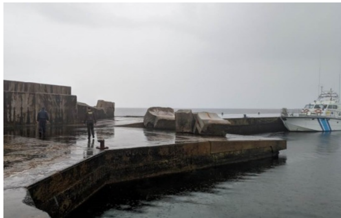
Foto 46. Estado del espaldón con sus restos sobre el muelle de la Isla de Alborán.
