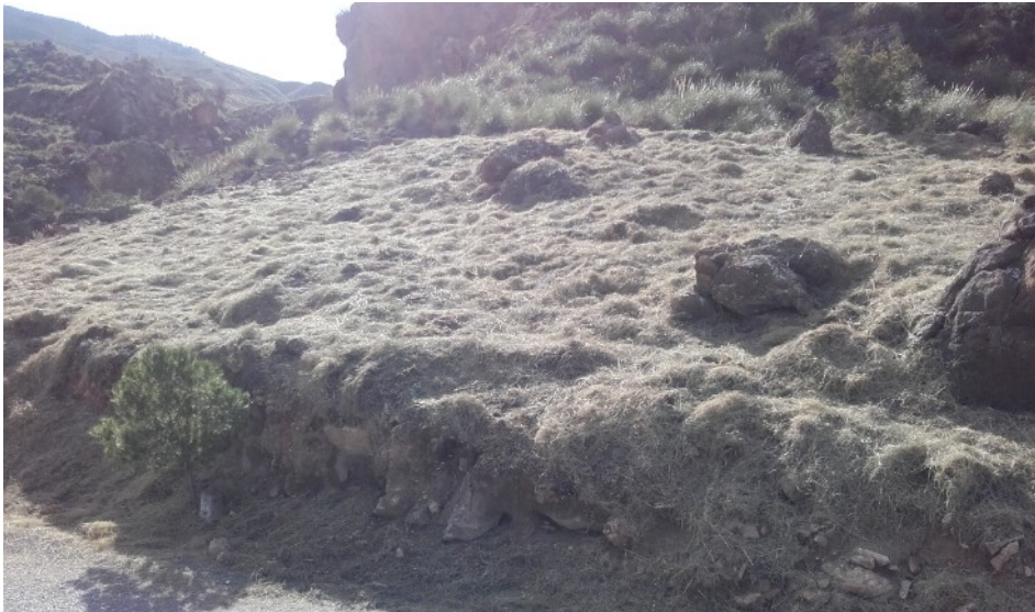
Fotos 20 y 21. (Arriba) Detalle de una de las actuaciones incluidas en el proyecto “Selvicultura preventiva contra incendios forestales en la Comunidad Autónoma de Andalucía (Almería)”. Pueden apreciarse las características del terreno durante la ejecución de la faja auxiliar. (Debajo) Posteriormente a la misma.
