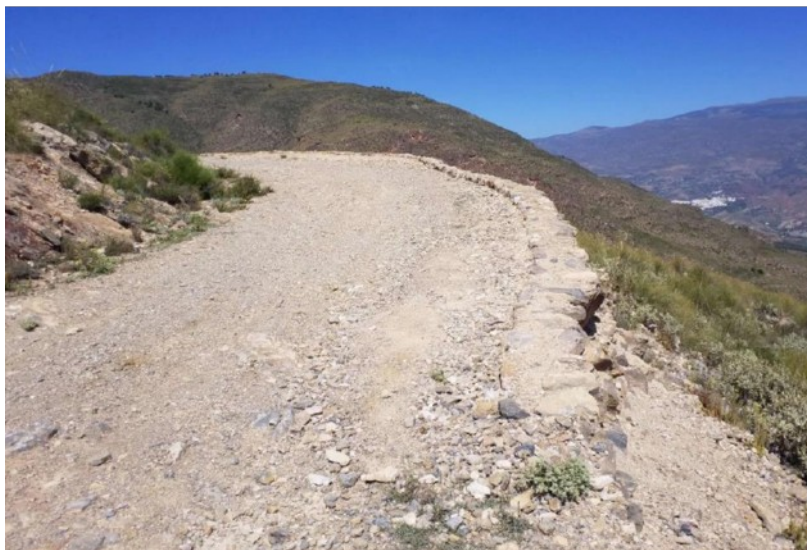
Foto 48 y 49. Detalle de actuaciones ejecutadas en el marco del servicio de modernización y mejora de los caminos forestales en la provincia de Almería en el camino Cuesta de la Fragua (AN3039), dentro del espacio ES6110008.
