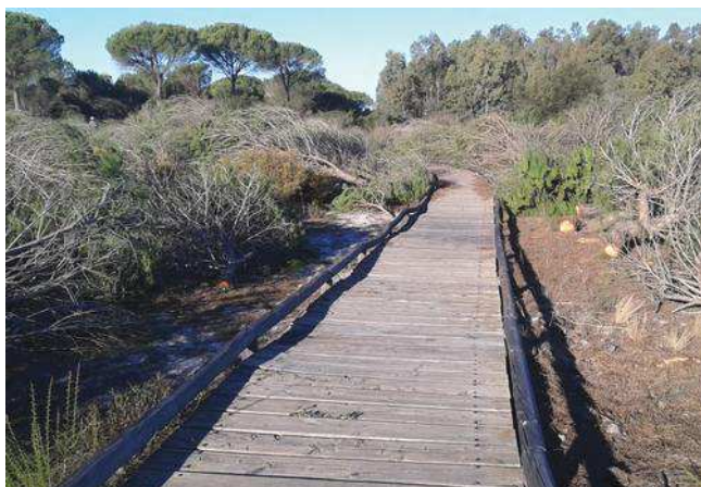
Vista general de la zona de actuación después de la corta
