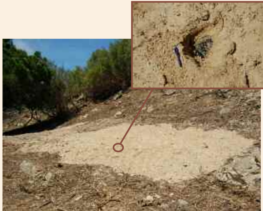
Fig. 31. Parcelle traitée sur laquelle a été placé un filet géotextile, sous une couche de sable de 5 cm environ pour éviter des déplacements ou un vol éventuel.
