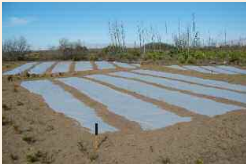
Fig. 19. Aspect de la parcelle couverte de géotextile après avoir débroussaillé les peuplements isolés. À noter que les bandes de géotextile ont été recouvertes de sable sur leur périmètre afin de les protéger du vent.
