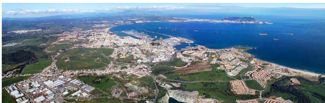
Estructuras urbanas complejas en la Bahía de Algeciras.
