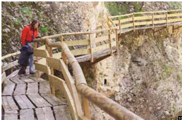
Pasarela colgante sobre el río
