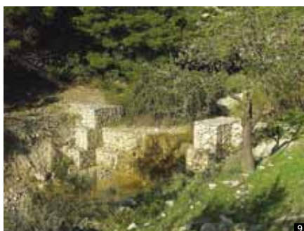
9 Presa de retención de materiales
