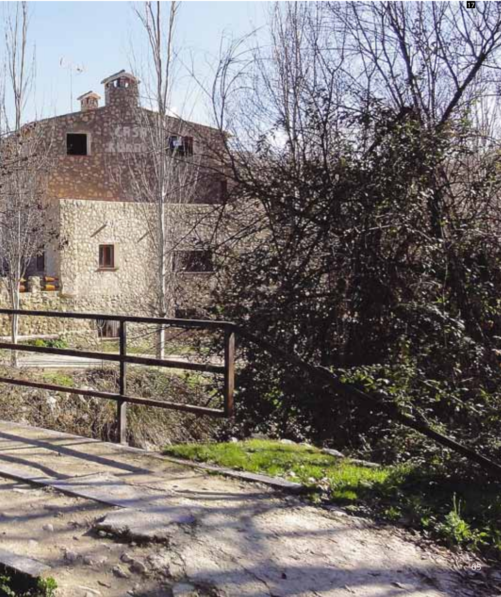
Molino de las Tres Piedras junto a uno de los puentes que cruza el río Castril
