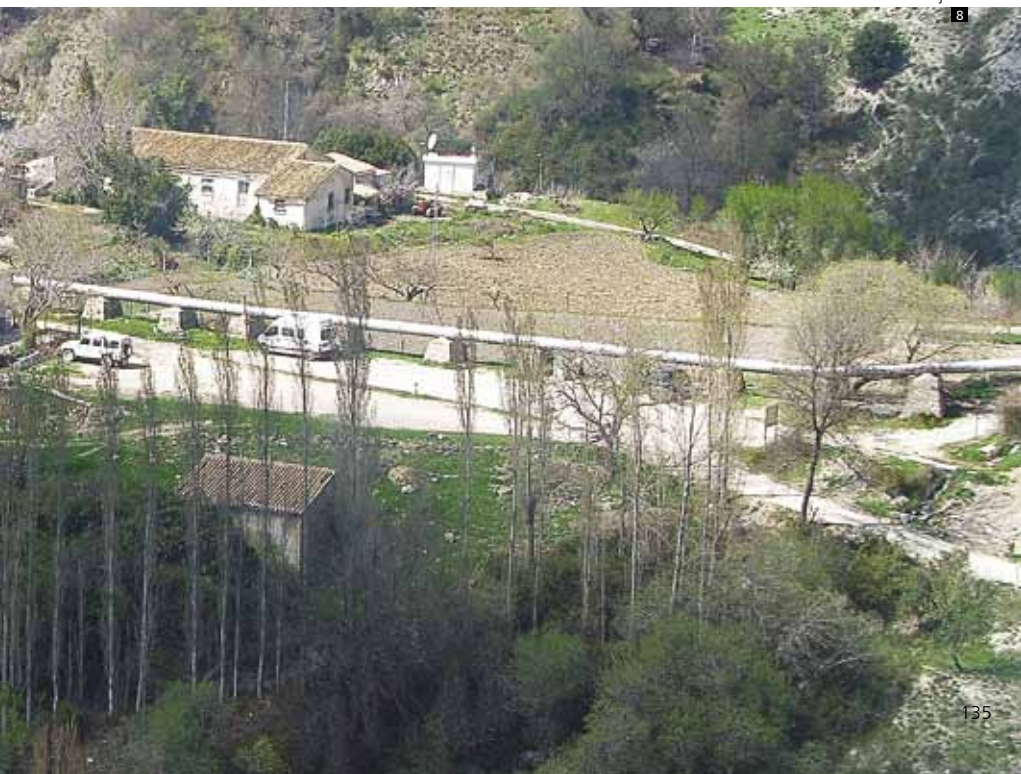
Tubería de acero de la central atravesando la cortijada
