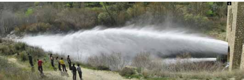
Desagüe que libera el agua embalsada
