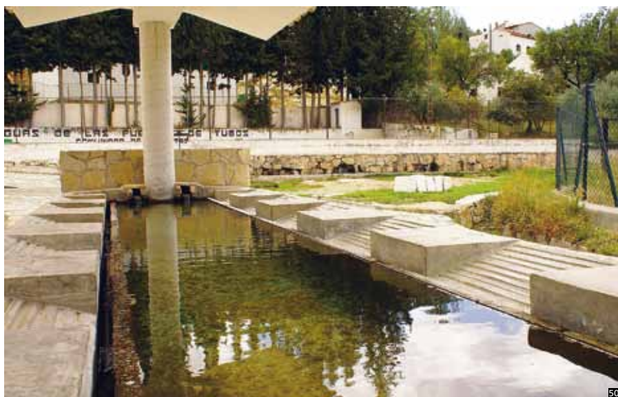
Lavadero de los Tubos 50
