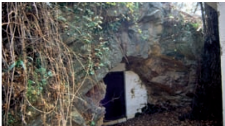
Captación de agua en una zona de alumbramiento asociada a la charnela de un pliegue en los materiales cuarcíticos del Salto Padilla.
