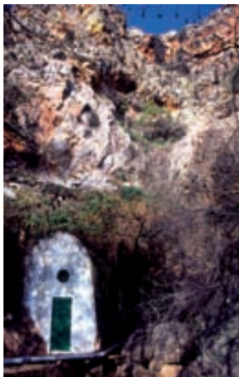
Captación de los manantiales del Salto del Fraile para abastecimiento a la población de La Carolina.
