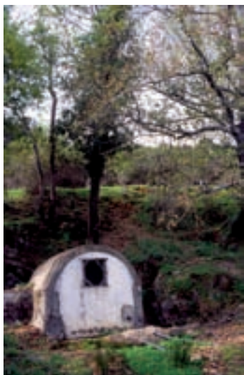
La captación de estos pequeños manantiales soluciona problemas de abastecimiento a núcleos de población y constituyen un recurso imprescindible para las actividades ganaderas.
