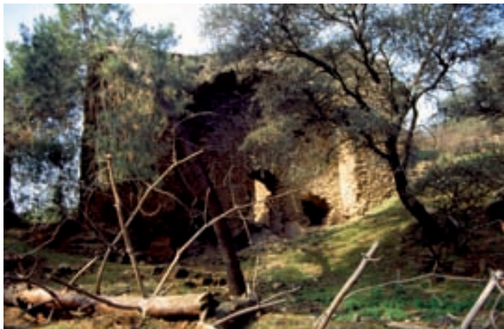
Restos de las edificaciones del antiguo Molino del Batán.
