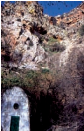
Infraestructura de captación de los manantiales del Salto del Fraile.
