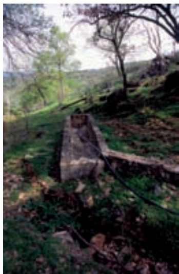
Abrevadero en el entorno del manantial del Pilarillo.
