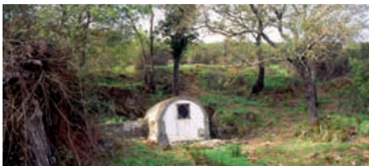
Caseta de captación del manantial del Collado de los Jardines.
