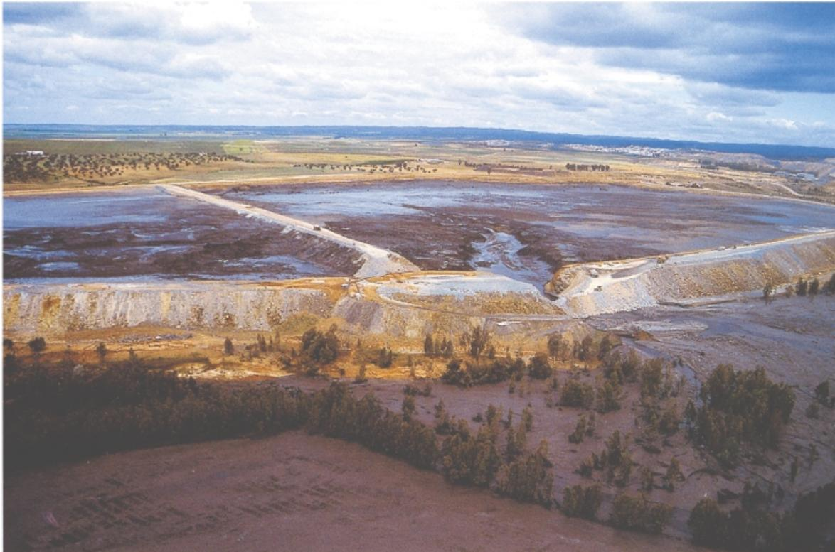
Foto 1. Zona de rotura de la balsa de estériles.
