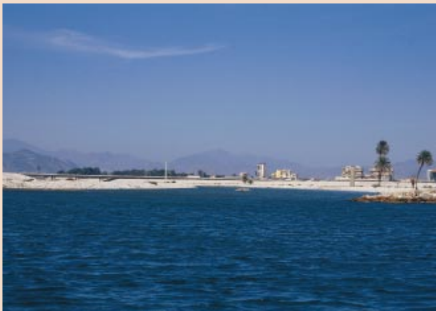
■ El tramo final del río Guadalhorce ha sido encauzado recientemente, modificando su curso.
