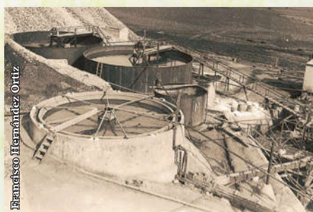
Instalación metalúrgica aurífera por cianuración en la planta Dorr funcionando en 1935.
