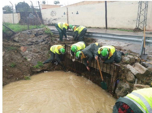
La BRICA de Málaga colabora en limpieza de punto de desagüe en Cártama.
