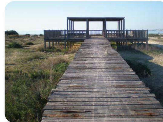
*Para evitar el posible daño de los recorridos por el parque, se han diseñado una serie de elementos de madera ( con traviesas de ferrocarril recicladas) que flotan sobre el terreno. Las pasarelas y miradores van integrándose así al paisaje natural, facilitando el acceso a los lugares de especial interés.*
