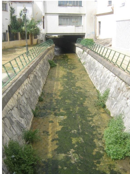
Figura nº 6. Encauzamiento del río Ubrique a su paso por el núcleo urbano de Ubrique
